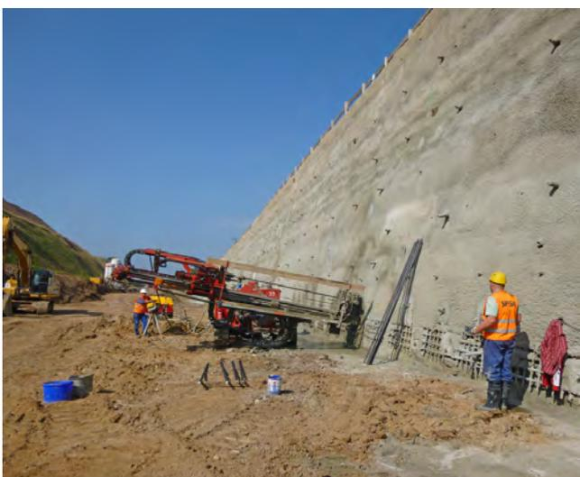
5 Spritzbetonarbeiten im Zuge der Herstellung der Bodenvernagelung im Bereich Tunnel Hain
