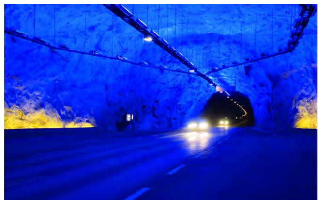
Mehr als 1800 Straßen- und Eisenbahntunnel durchziehen Norwegen auf einer Länge von mehr als 1000 km. Der Lærdal Tunnel (Foto) ist mit 24,5 km der längste Straßentunnel der Welt. Er verfügt über variierende Beleuchtung und eine kurvige Streckenführung zum Schutz vor Ermüdung
