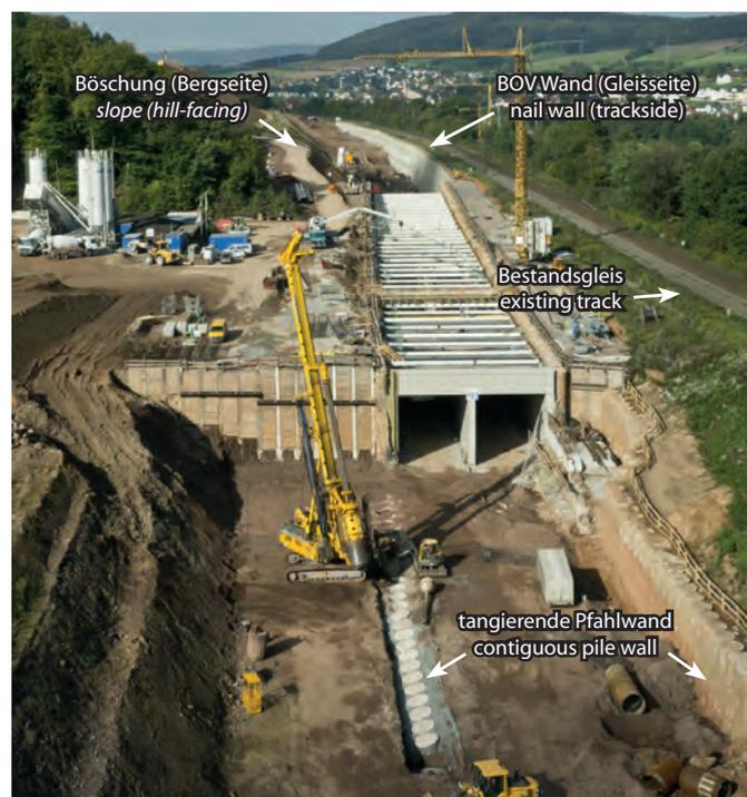
3 Offene Bauweise Tunnel Hain: Tangierende Pfahlwand, Böschung und Bodenvernagelung neben Bestandsgleis
