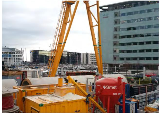
Aus dem Vorratssilo (rechts) wird der Bentonit über eine Förderschnecke in die Suspensionsmischanlage SKC-60-C transportiert (links). Die Bentonitsuspension wird im dahinter zu sehenden Rührwerksbehälter zwischengelagert und über eine Druckleitung in den Tunnel gepumpt
