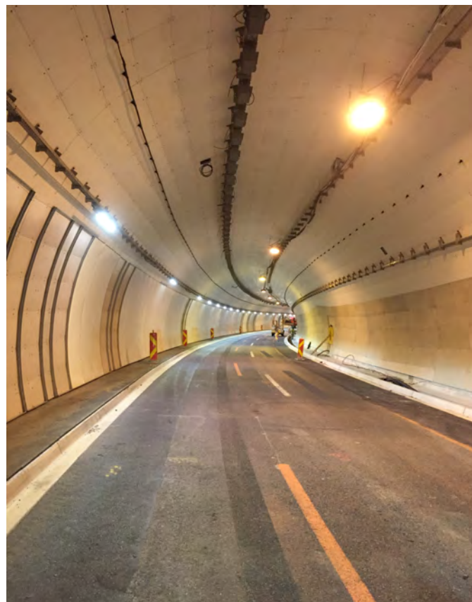
Abschließend erhielt die Tunnelwand eine architektonische Bekleidung, die vor die Brandschutzbekleidung montiert wurde. Im Bild gut erkennbar die dafür bereits montierte Unterkonstruktion
