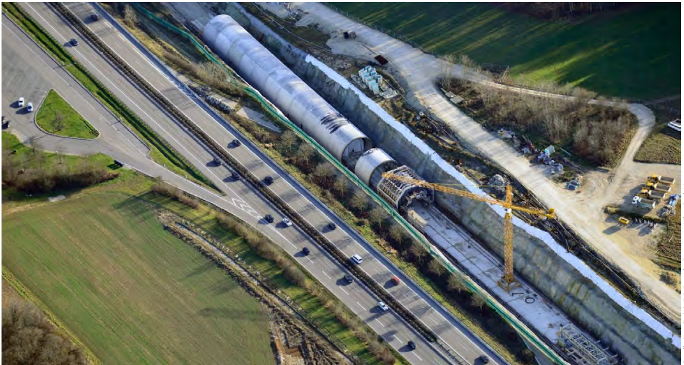
10 Ein Turmdrehkran bediente zentral vier Betonierbaustellen – zwei Sohlblöcke und zwei Gewölbeblöcke. Dabei wurde stets auf Lücke betoniert A tunnel tower crane served four concreting sites from a central position – two invert blocks and two arch blocks. Concreting was always carried out with gaps
