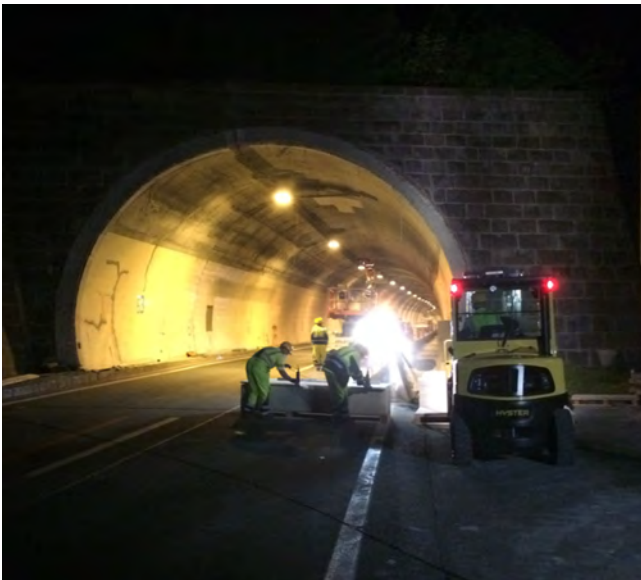
Auf der Brennerautobahn wurde mit dem Bergisel-Tunnel einer der am meisten befahrenen Streckenabschnitte modernisiert
