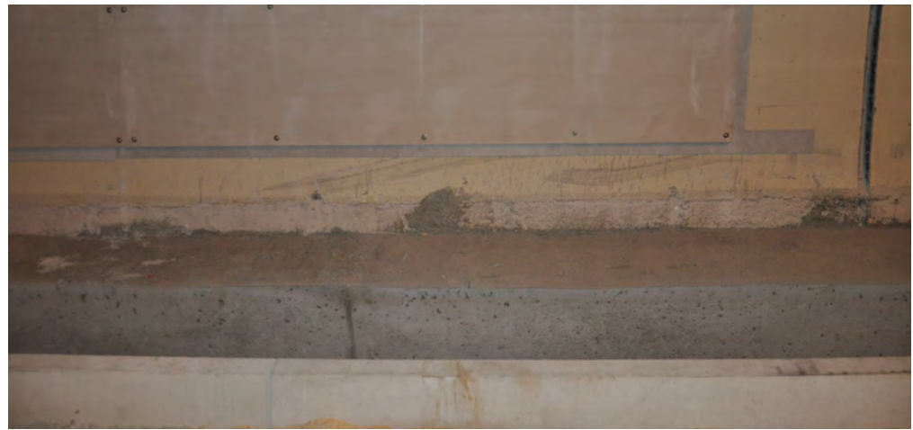
Bei der Montage war eine maximale Fugenbreite von 3 mm zulässig. Die Fugen wurden mit einem 100 mm Plattenstreifen in 10 mm Dicke hinterlegt (im unteren Bildteil zu erkennen). Dies schützt vor Branddurchschlag im Fugenbereich
