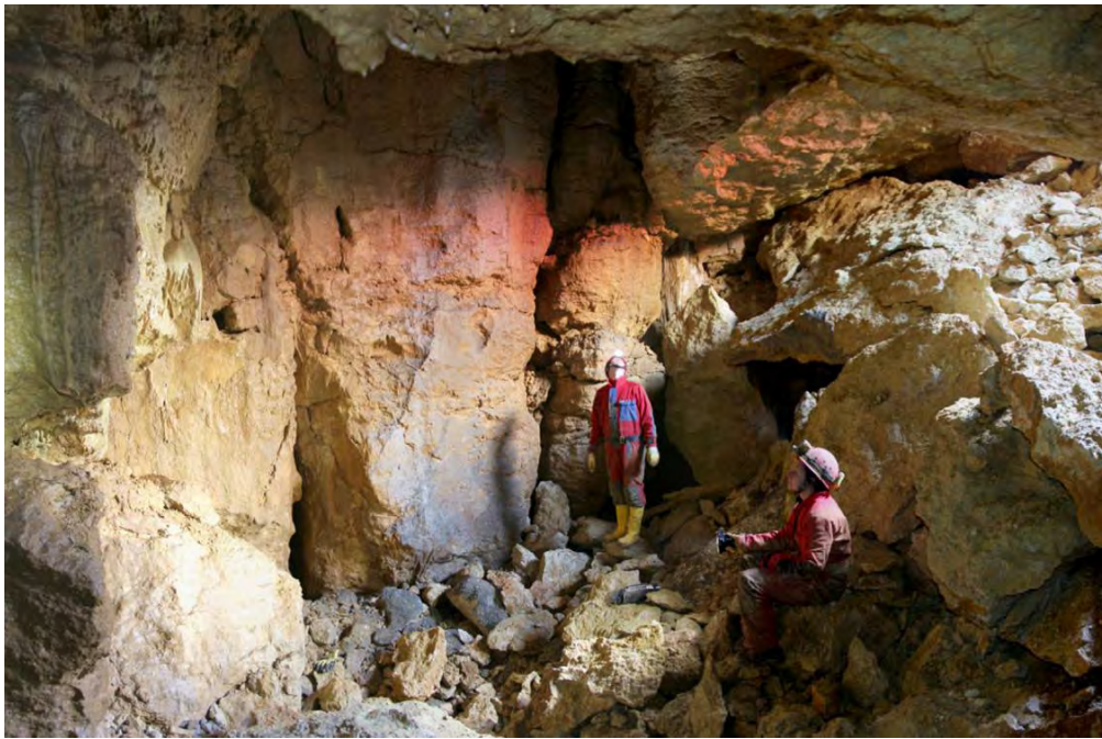
15 Am Tunnel Widderstall wurde der bisher größte Karsthohlraum auf den Baustellen der Albhochfläche entdeckt
