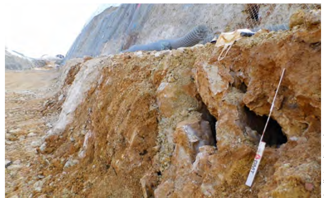
11 Karsthohlräume in der Baugrubenböschung Karst cavities in the construction pit slope
