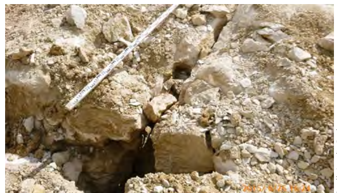
12 Offene Karstspalte in der Baugrubensohle Open karst cleft in the construction pit base
