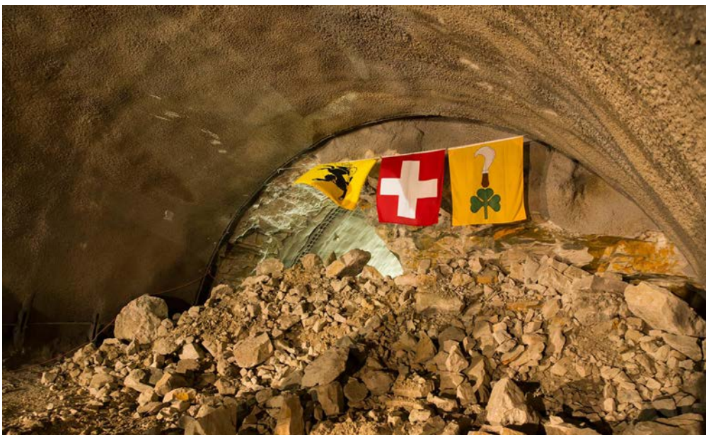
Nach zweieinhalb Jahren Bauzeit fand im Februar 2016 der Durchschlag am Galgenbucktunnel statt The Galgenbucktunnel had its breakthrough in February 2016 after two and a half years of construction
