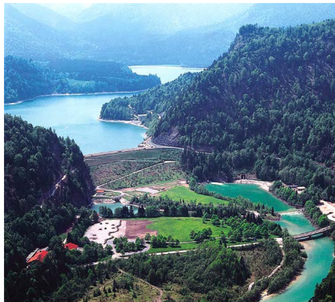
1 Talsperre Sylvensteinspeicher mit einem Rückhaltevolumen von 79 Millionen m 3
