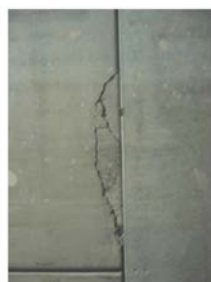
1 Beschädigungen des Tübbingausbaus Damage to the tunnel lining
