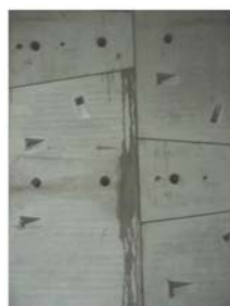
1 Beschädigungen des Tübbingausbaus Damage to the tunnel lining
