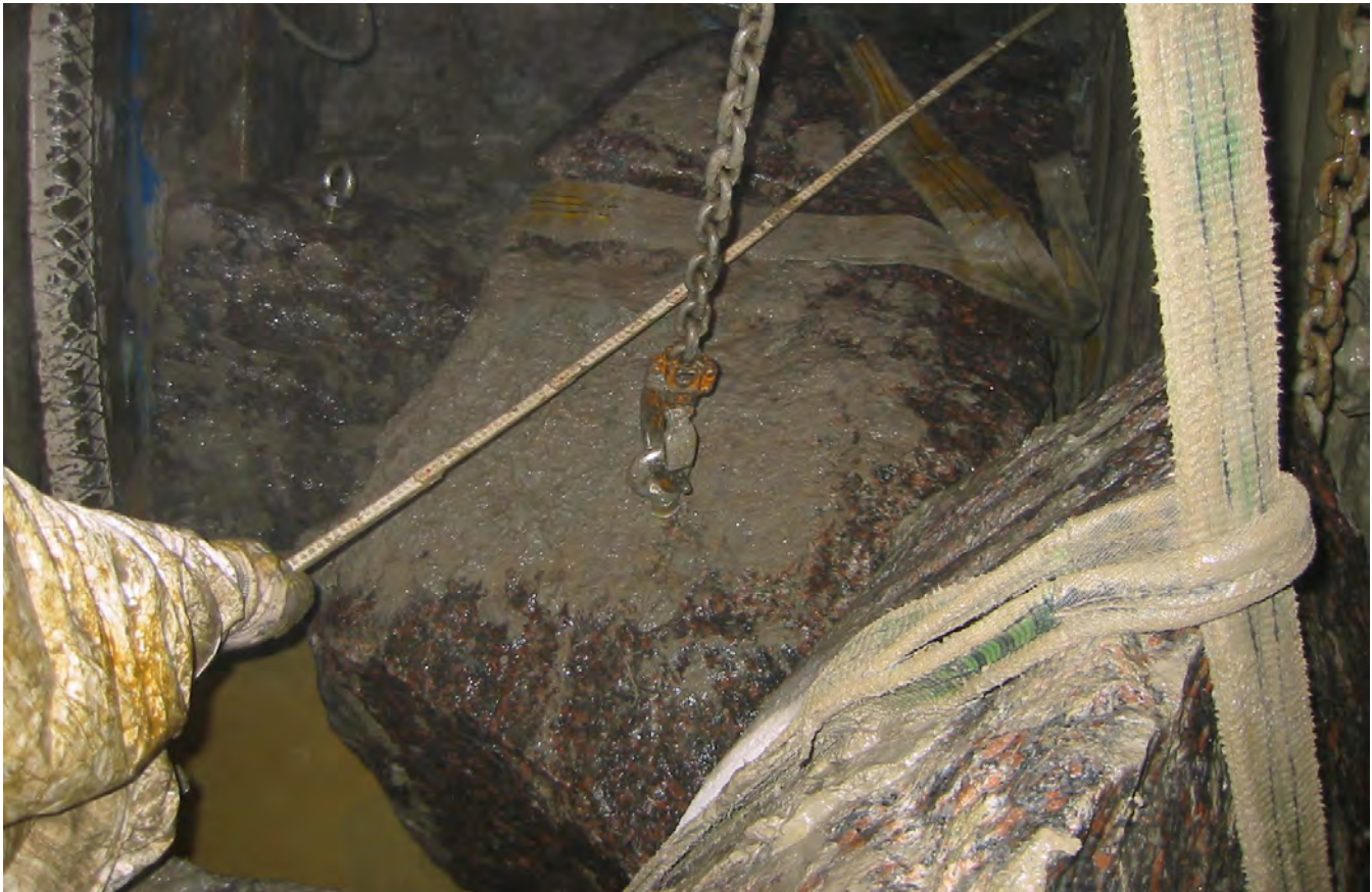
Hindernisbergung unter Druckluft am Schneirad im Herrentunnel Lübeck Obstacle removal in compressed air at the TBM cutterhead in the Herrentunnel, Lübeck
