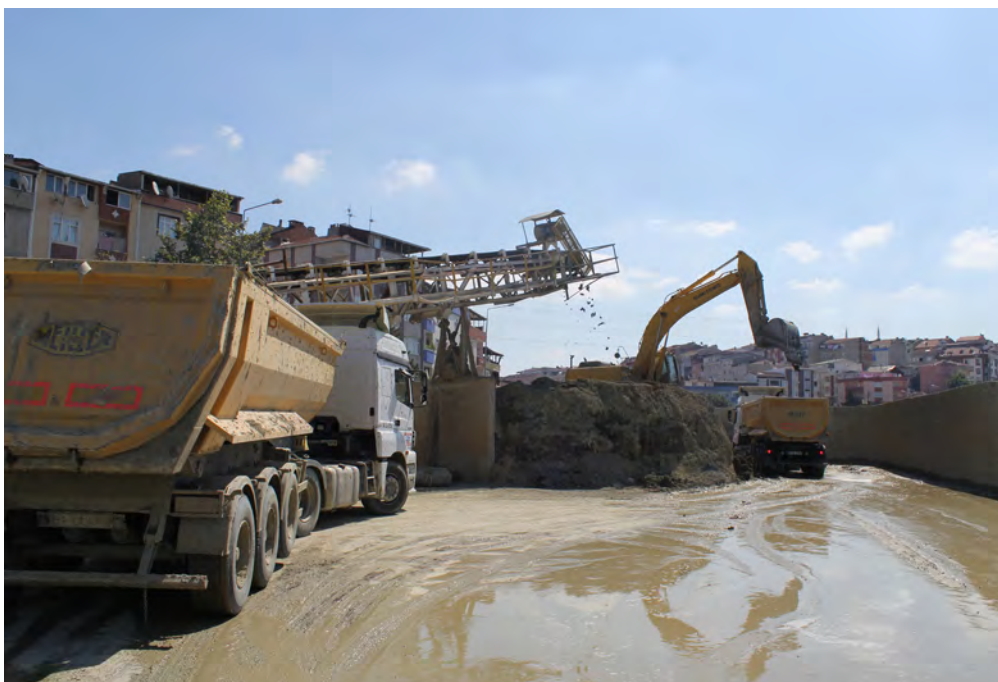
Verladung des Tunnelausbruchs zum Abtransport von der Baustelle per LKW
