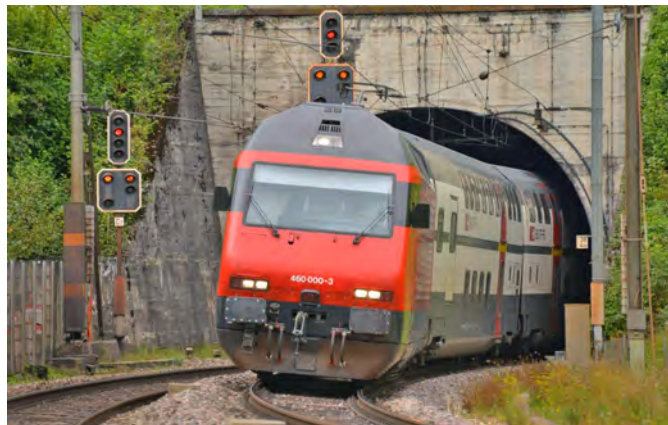
Nah dem Südportal des bestehenden Tunnels bei Schinznach-Dorf soll ab Frühjahr 2016 der Tunnelvortrieb für den Bau des neuen Bözberg-Eisenbahntunnels starten
