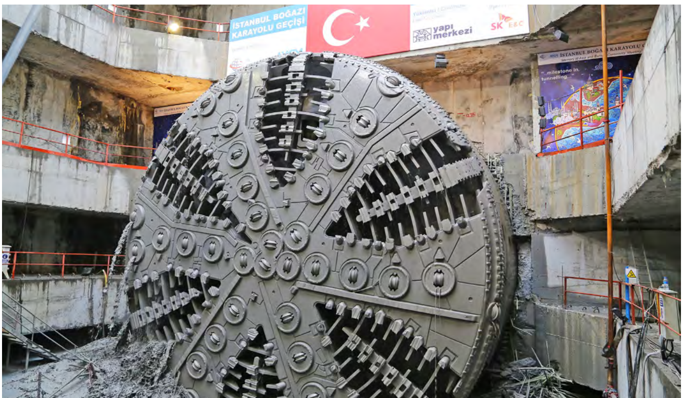
Das Schneidrad der 13,66 m großen TBM kurz nach dem Durchstich im Zielschacht des Eurasia-Tunnels auf der europäischen Seite des Bosporus
