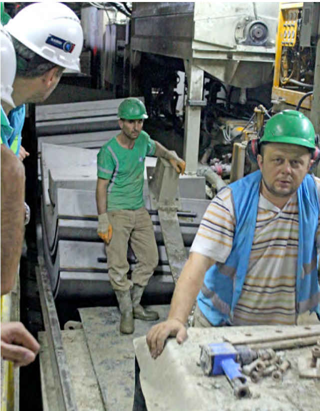
Anlieferung von weiteren sechs Tübbinggen für den nächsten Ringbau der Terratec-TBM
