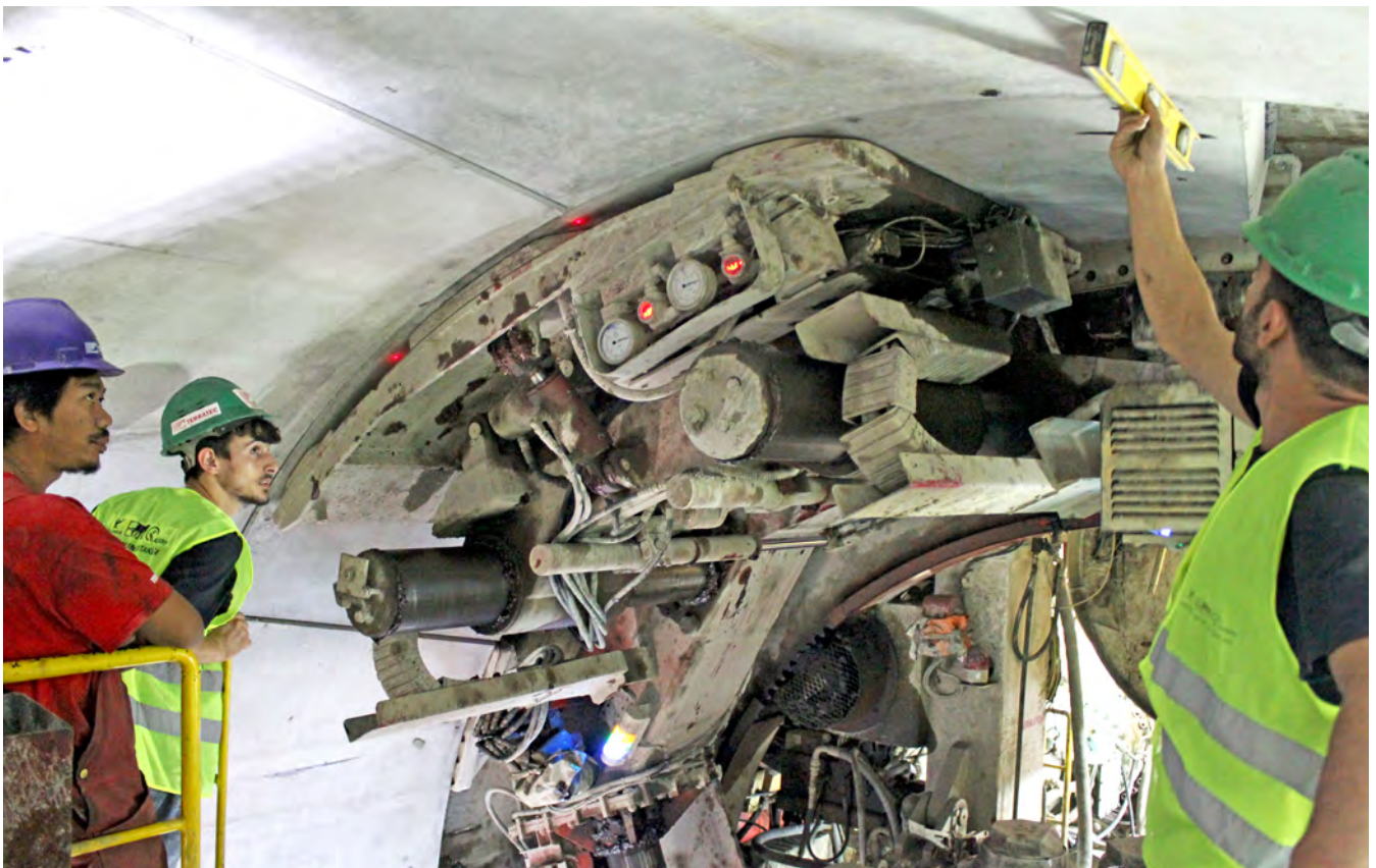
Vortrieb in Richtung Veysel Karani: Platzierung der Tübbinge im Tunnel
