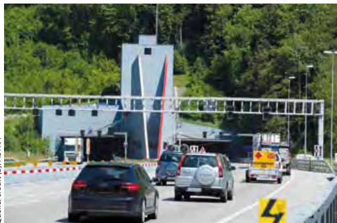
Täglich durchfahren im Mittel nicht weniger als 55 000 Fahrzeuge den Belchentunnel
