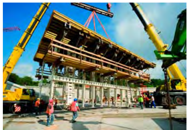
Versetzen eines Deckenschalwagens am Tunnelabschnitt Ost, offene Bauweise
