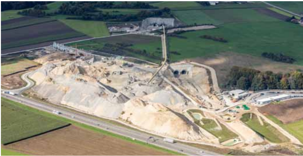
Die Baugrube Pfaffenäcker und die Baustelleneinrichtungsflächen rund um das Portal Hohenstadt des Steinbühltunnels
