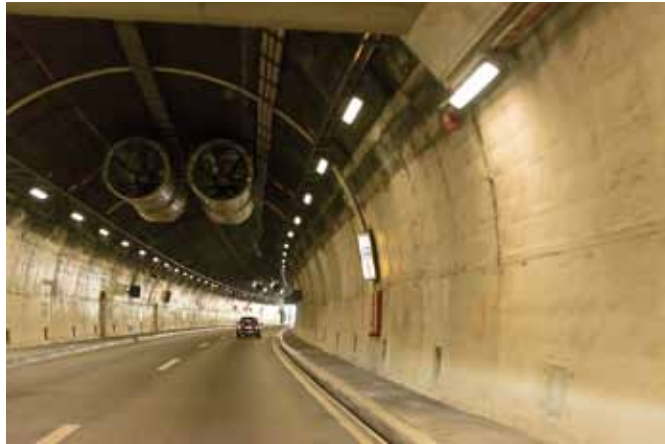
Das ASTRA hat seit 2008 128 Millionen Schweizer Franken in die Sicherheit des Belchentunnels auf der Autobahn A2 investiert
