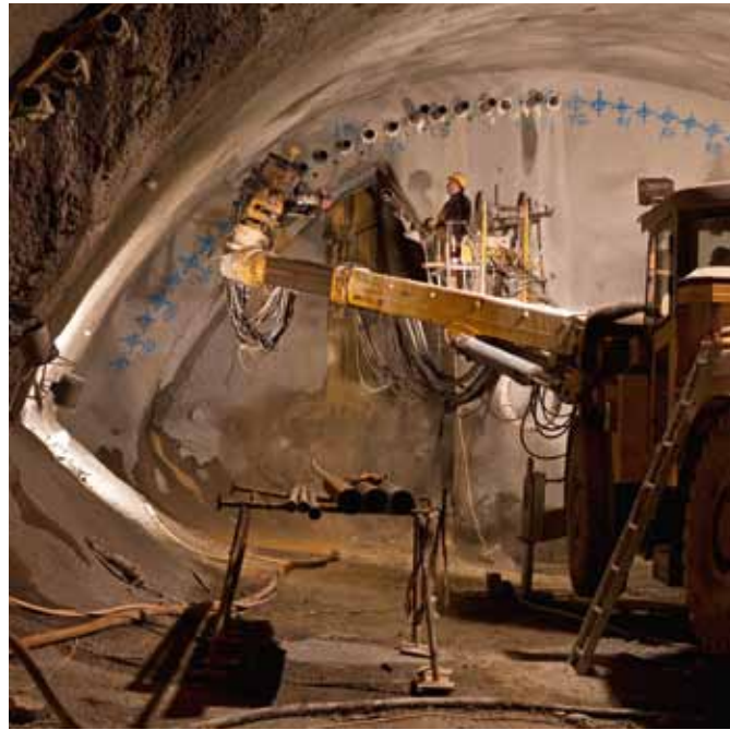
Absicherung der Vortriebsarbeiten durch den Einsatz eines Rohrschirms Securing the driving activities by using a pipe umbrella
