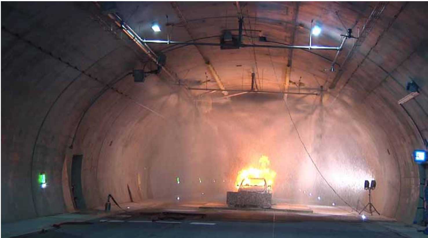
Test der Brandbekämpfungsanlage – der Schaum wird freigesetzt The fire extinguishing system being tested – foam is released
