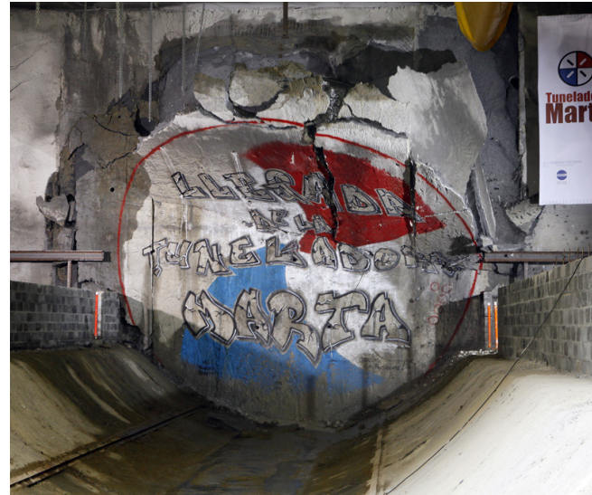
Ein großes Ereignis für Bauarbeiter und Öffentlichkeit: Der Durchbruch der TBM „Marta“ an der Station 5 de Mayo A big event for the construction workers and the public: Breakthrough of the TBM “Marta” at the Estación 5 de Mayo
