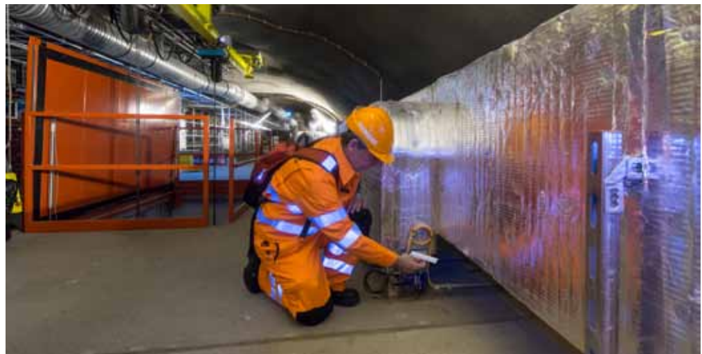
Auch das Lüftungssystem (im Bild: das System der Multifunktionsstelle Faido) wird über das Tunnelleitsystem gesteuert
