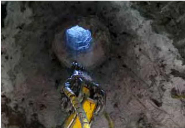
Abwasserstollen „Southeast Collector“: Herstellung eines Verbindungsschachtes im vereisten Untergrund
