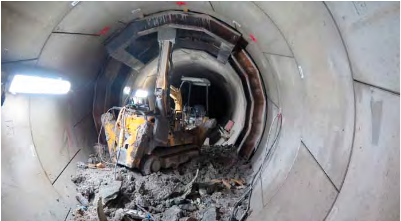
Beengte Arbeitsverhältnisse: Verbindung eines Lüftungsschachts mit der SeC-Tunnelröhre Constricted working conditions: connecting a ventilation shaft with the SeC tunnel bore
