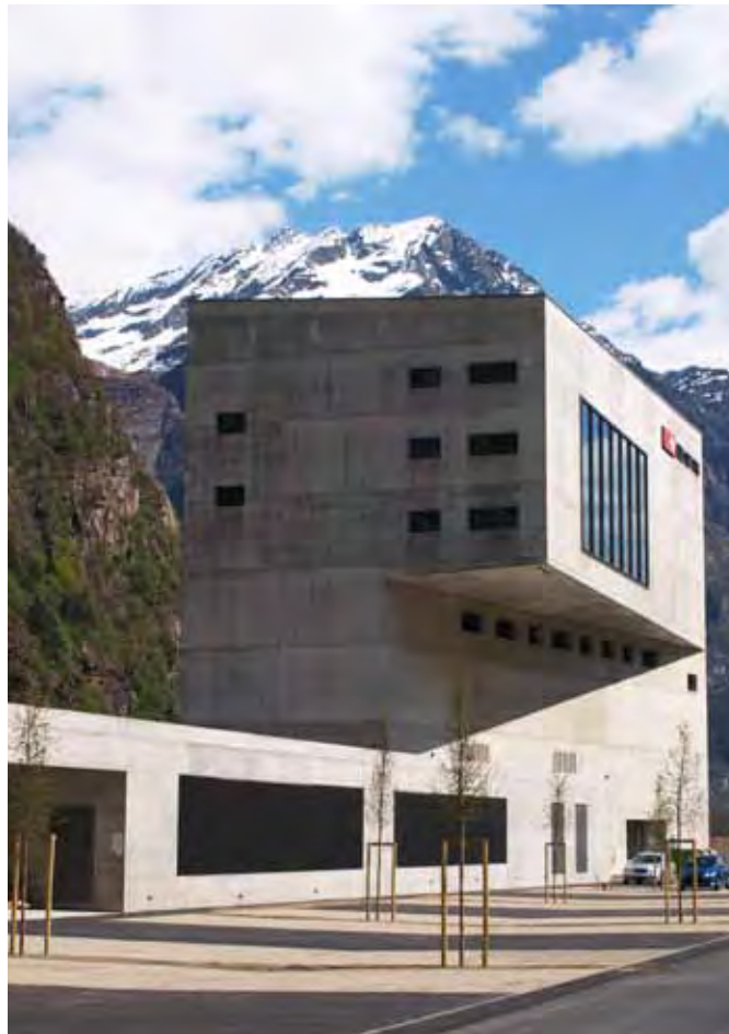
Um den einwandfreien Eisenbahnbetrieb des Gotthard-Basistunnels sicherzustellen, ist eine permanente Verfügbarkeit des Gesamtsystems unabdingbar. Die dafür notwendigen Tunnelleitsysteme sind in den zwei Tunnel-Control-Centern (TCC) am Süd- und Nordportal untergebracht. Im Bild: Die „Centrale d'esercizio di Pollegio“, kurz CEP, am Südportal des Gotthard-Basistunnels
