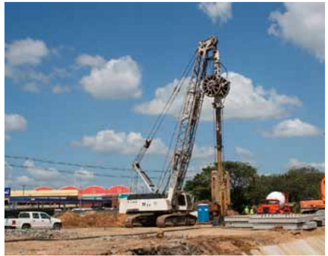
Bauarbeiten Albrook Terminal – Startpunkt der TBM S-680 „Marta“ im Januar 2012
