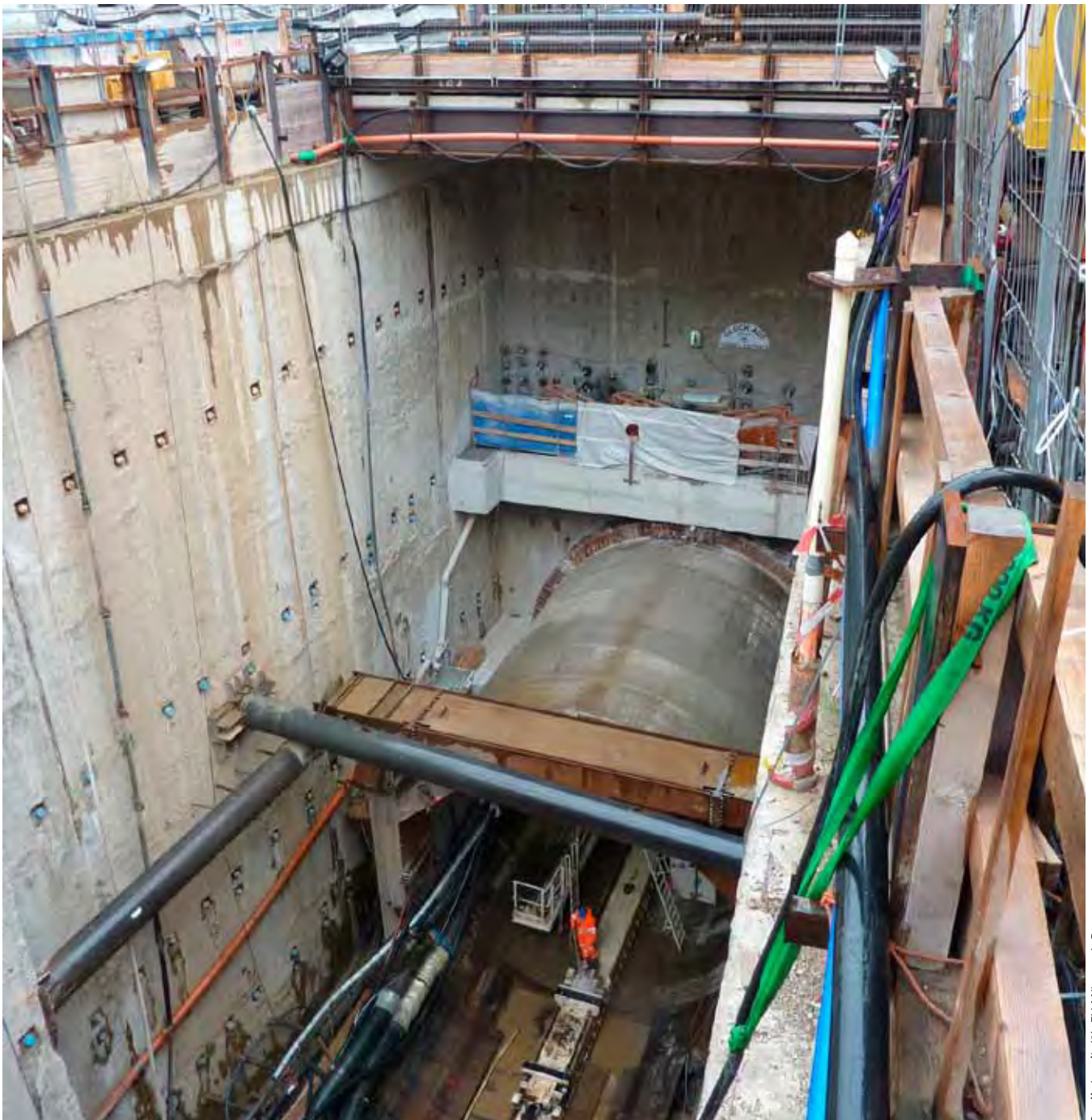
13 Schlitzwände eines Startschachtes beim Tunnelbau für die Wehrhahnlinie in Düsseldorf
