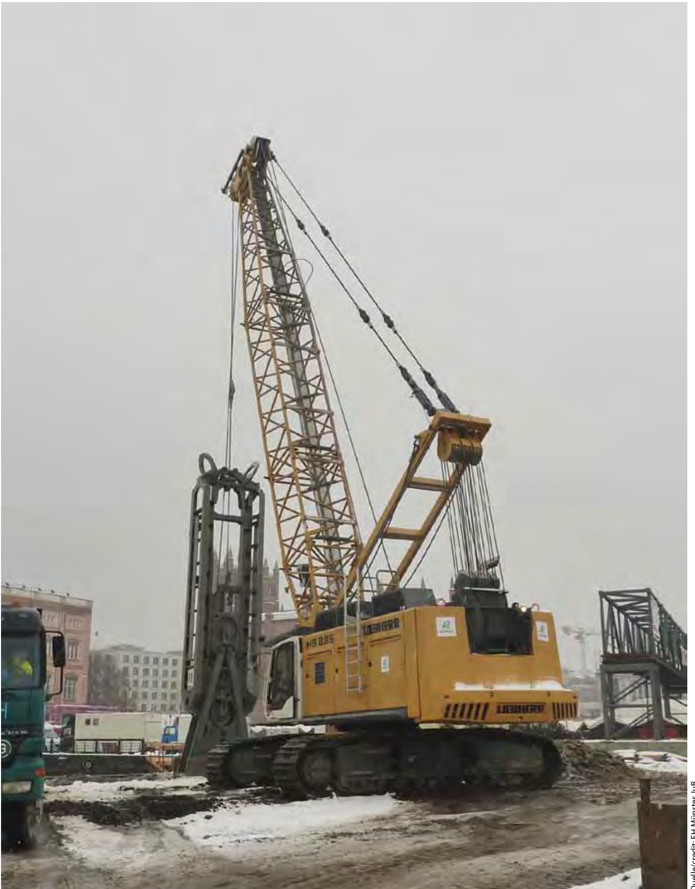
1 Hydroseilbagger bei der Erstellung einer Schlitzwandlamelle Hydraulic Rope Excavator producing a diaphragm wall lamella
