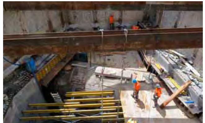
Vorbereitungen zum Anschluss an den bestehenden Abwasserkanal
