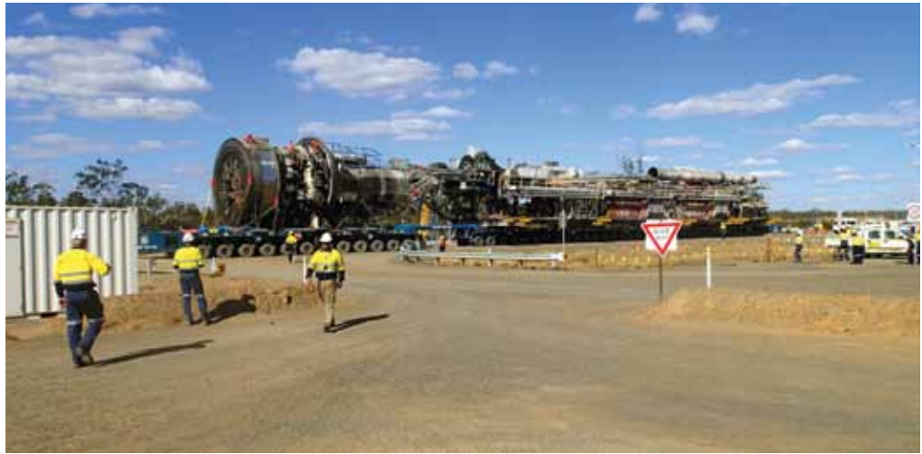
Unter Verwendung speziell konzipierter Transportkarren wurde der TVM-Kern zurück an die Oberfläche geholt und für die Arbeit am zweiten Tunnel vorbereitet
