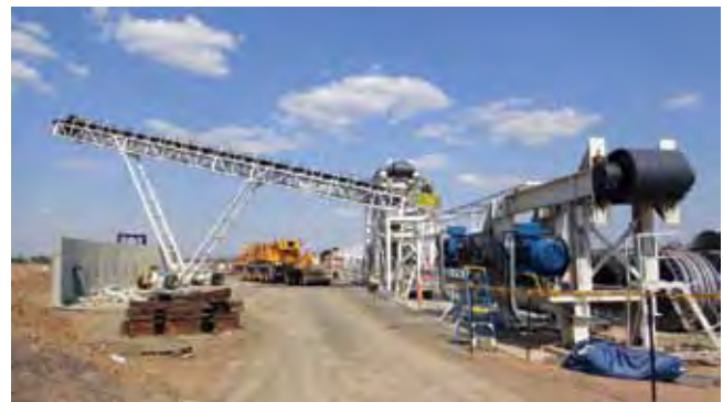
Mit Tunnelförderbändern wird das Ausbruchsmaterial abtransportiert Continuous conveyors operate behind the TBM for muck removal
