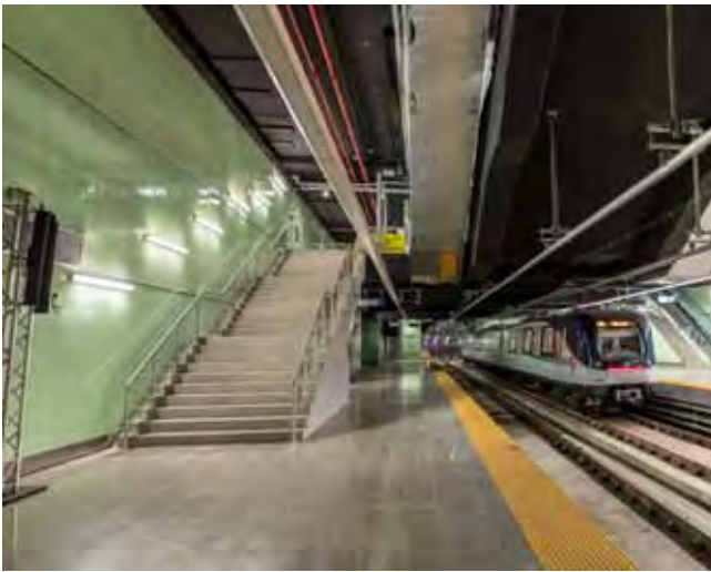
Der Bau der Metrolinie 1 von Panama-Stadt dauerte 20 Monate. Das neue Transportsystem wurde Anfang April 2014 in Betrieb genommen
