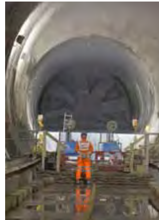
Durchbruch der TBM Ellie in die Stepney Green Kaverne
