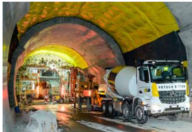
Küblistunnel: Alternierendes Betonieren der Innenringe in 10 m langen Sektionen
