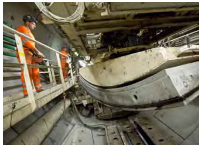
Einbau der Tübbinge im Tunnel
