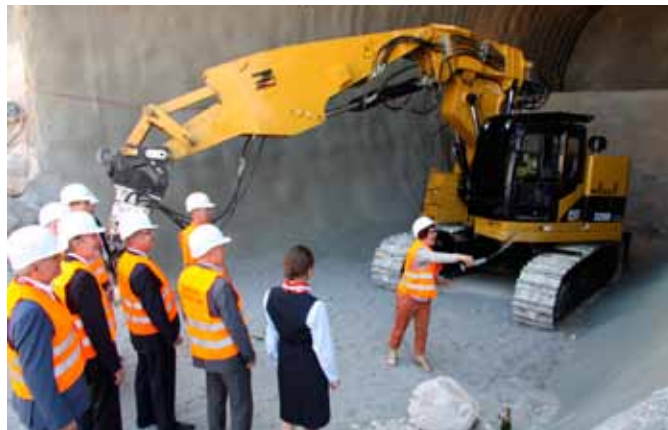
Gerlinde Kretschmann, die Gattin des Ministerpräsidenten von Baden-Württemberg, läutete als Tunnelpatin den Baustart des Albabstiegstunnels ein
