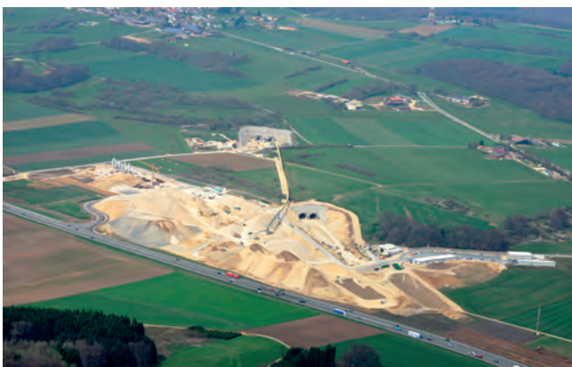
Steinbühlentunnel: Portal Hohenstadt Steinbühl Tunnel, Hohenstadt portal
