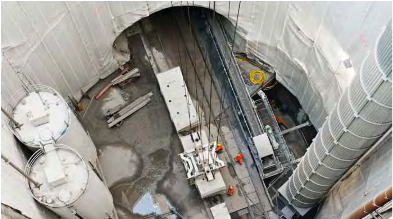
Tübingverladung durch den Bauschacht Transferring segments through the construction shaft
