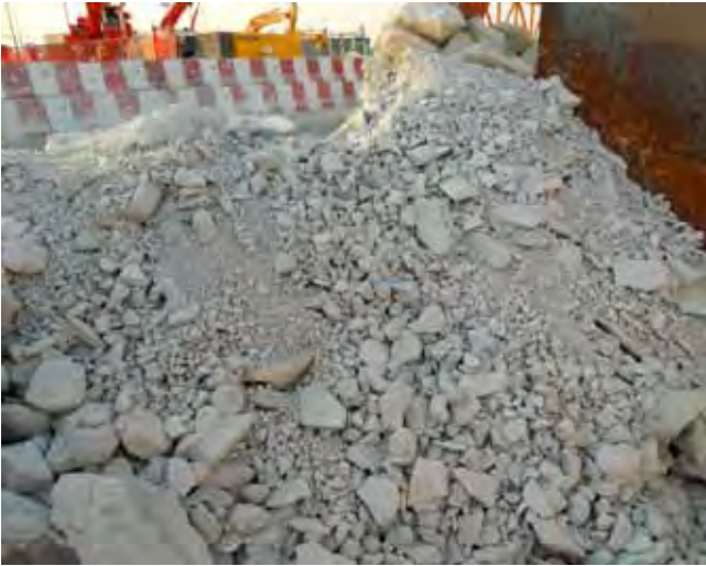
Abbruchmaterial ohne Konditionierung bei einem EPB-Projekt in Wechselgestein mit Kalkgips und Schlammtön
