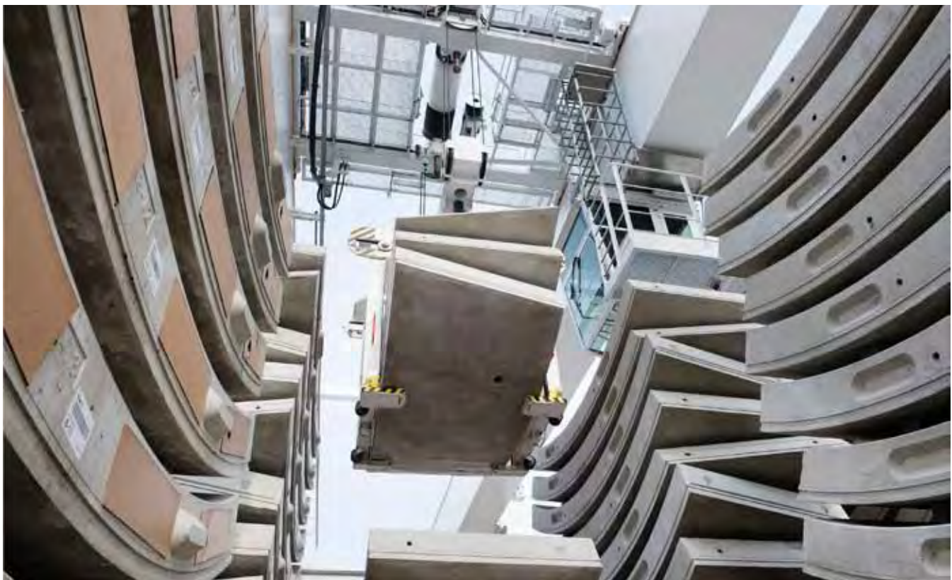
Verladung von Tübbing mit dem Portalkran im Tübbinglager des Koralmtunnel KAT2
