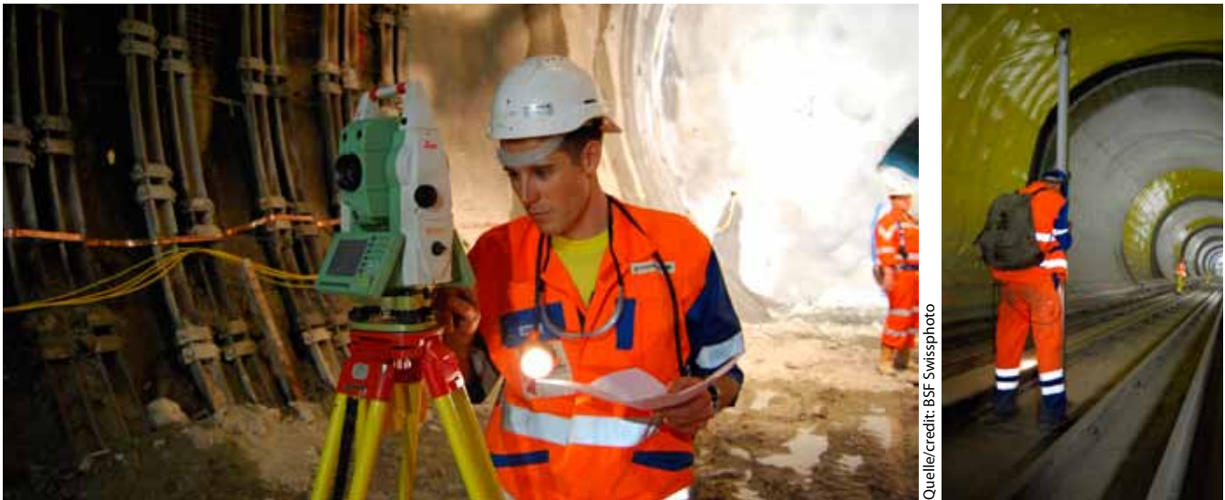
Vermessungsarbeiten: Vermesser beim Polygonzugmessen mit Totalstation und Messtruppe beim Nivellement
