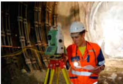
Vermessungsarbeiten im Gotthard Basis Tunnel: Vermesser beim Polygonzugmessen mit Total- station
