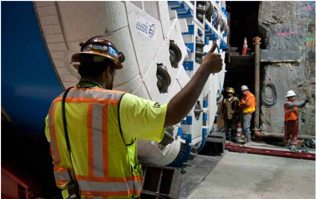
Zwei EPB-TVMs von Robbins führten Vortriebsarbeiten für das San Francisco Central Subway Projekt mit strengen Setzungsbegrenzungen von nur 13 mm aus At the San Francisco Central Subway in California, USA, two Robbins EPBs excavated urban conditions with settlement limits as strict as 13 mm
