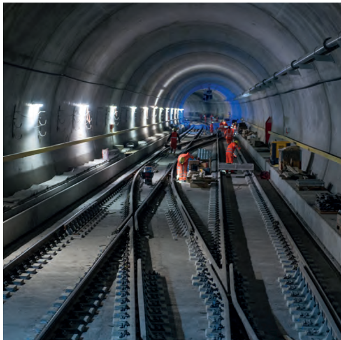
Arbeiten an der Gleisanlage im Weinbergtunnel Working on the Weinberg Tunnel's railway track
