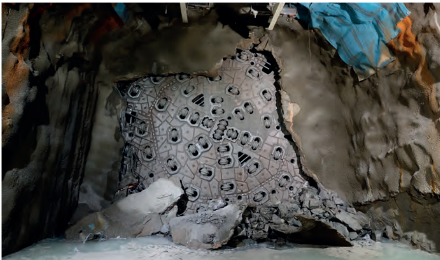
Der finale Durchschlag der TBM in Hallandsås-Tunnel
