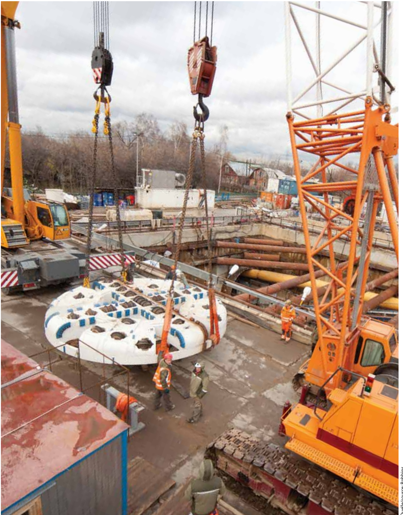
Ankunft eines Robbins EPB-Bohrkopfes an einer der zahlreichen Tunnelbaustellen in der dichtbebauten Moskauer Stadt Arrival of a Robbins EPB cutterhead at one of several small jobsites in the densely urban city of Moscow
