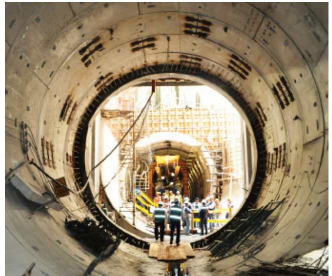
Fertige Tunnelröhre im ersten Bauabschnitt Finished tunnel section in stretch one
