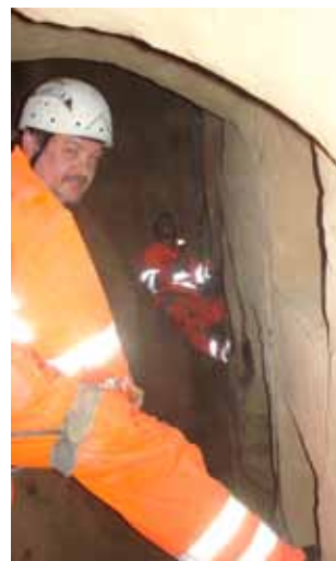
Martin Ziegler bei einem Besuch an der Ortsbrust im Katzenbergtunnel
