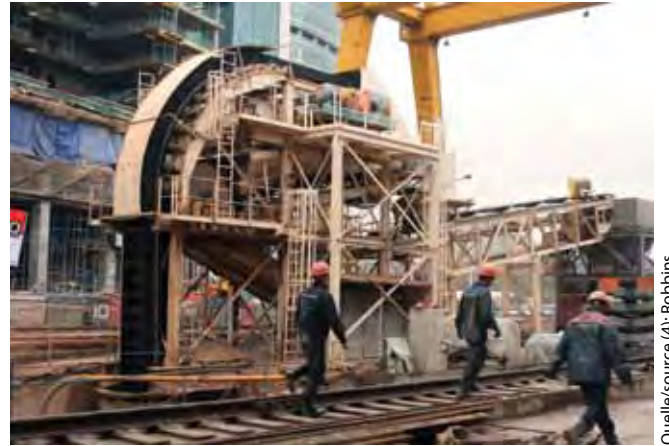
Bei beengten Platzverhältnissen kommen Tunnelbänder zum Einsatz um den Bohrgutaustrag abzutransportieren. Diese Engeocom-Baustelle befindet sich mitten zwischen Hochhausbebauung und einer Zufahrtstraße
