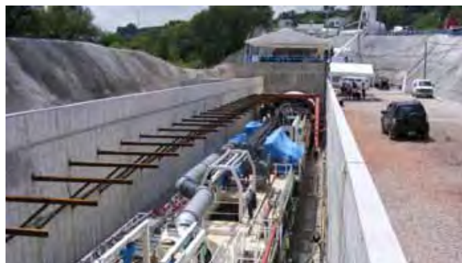
Offener Tunnelabschnitt mit Blick auf den Nachläufer einer EPB-Schild-Tunnelbohrmaschine
