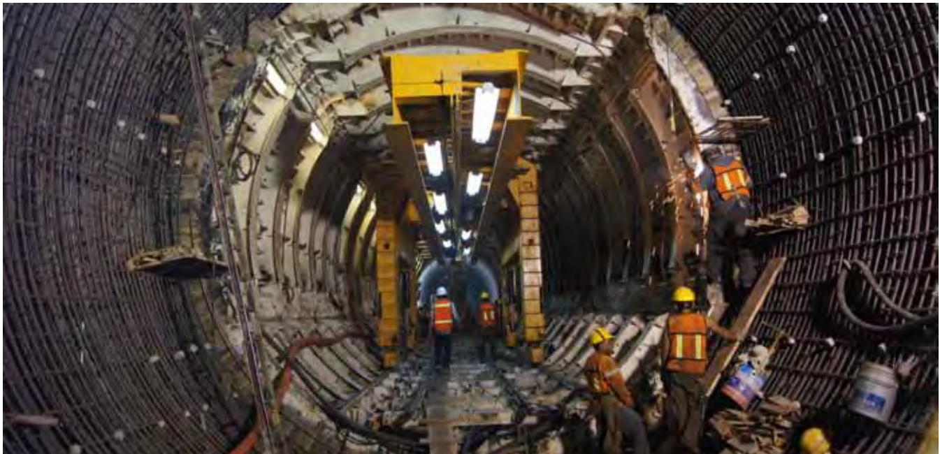
Die Metallarmierung für eine zweite innere Tunnelschale wird angebracht Metal formwork for placing the secondary lining of the tunnel
