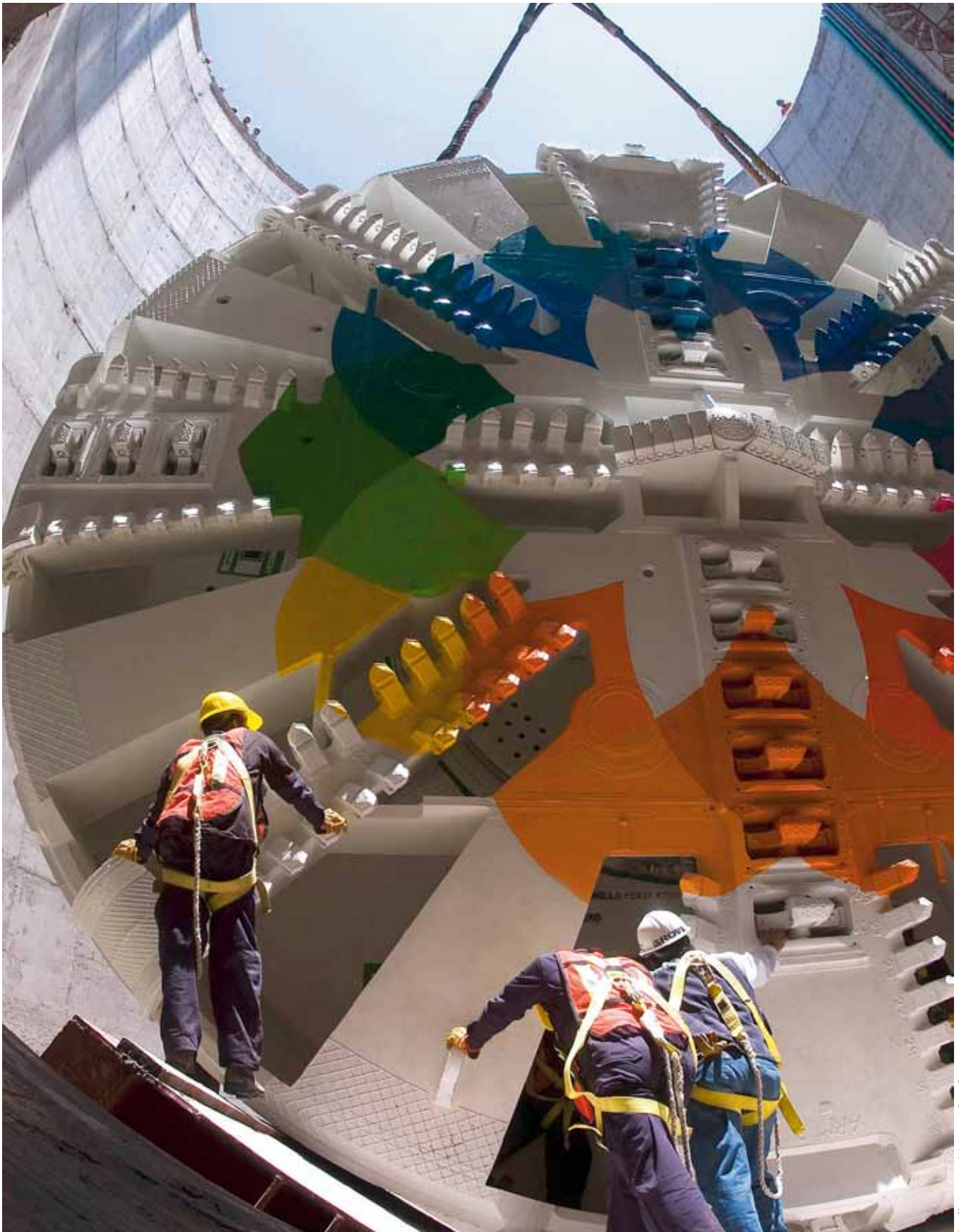
Maßarbeit: Die Montage des 8,7-Meter-EPB-Schildes S-497 von Herrenknecht erfolgte in einem nur 16 m großen Startschacht Precision work: Herrenknecht's 8,7 m wide S-497 EPB shield was assembled in a launch shaft of only 16 m diameter
