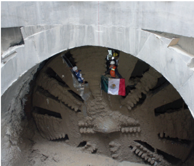
Arbeitsfortschritt: Die TBM hat einen Zuleitungsschacht erreicht Work in progress: The TBM has reached an inflow duct
