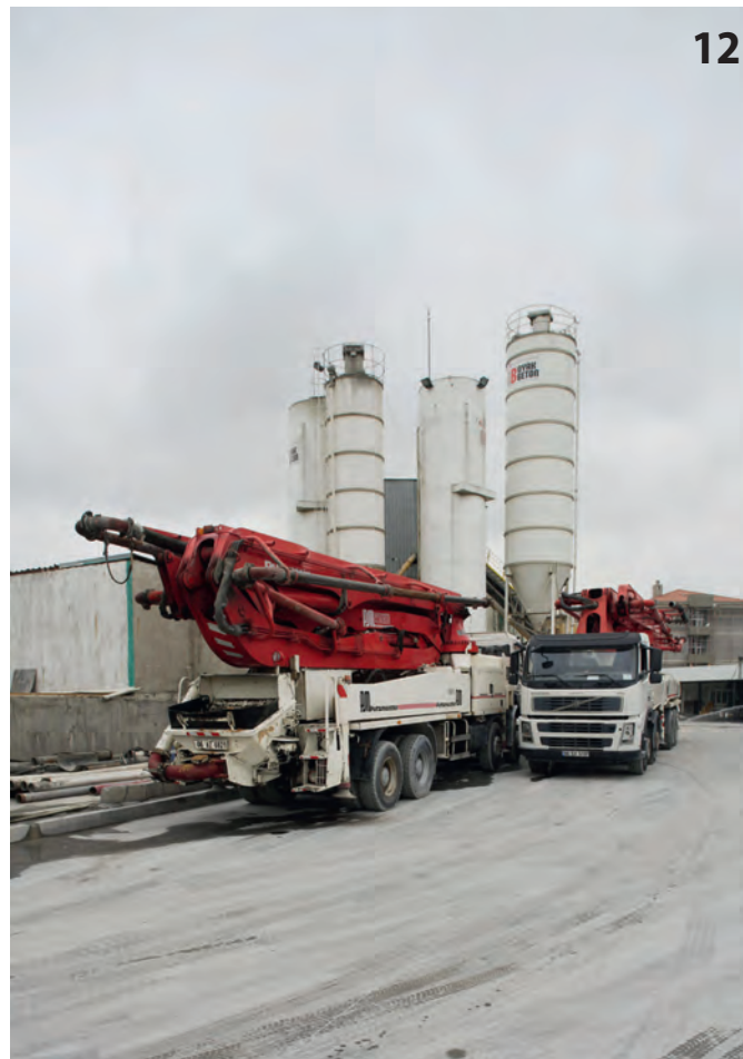
Zementsilos im Betonwerk von Oyak-Beton auf der asiatischen Seite der Stadt Cement silos in the Oyak Beton cement plant on the city's Asian side
