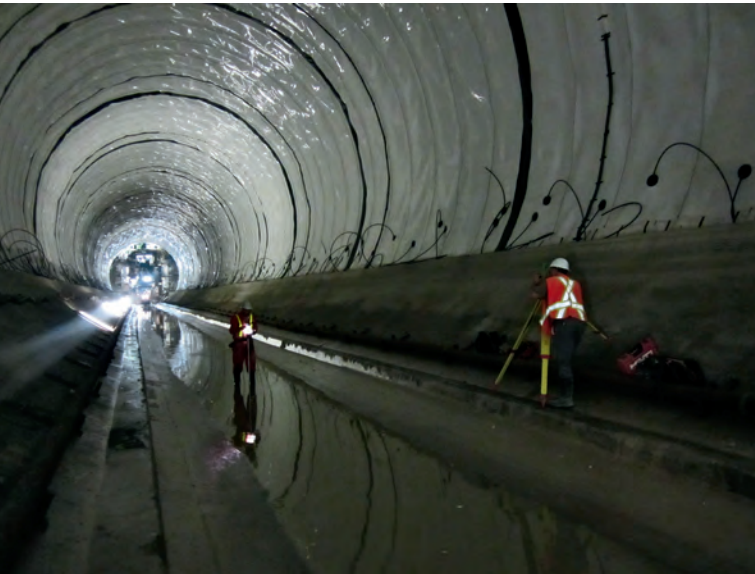
KDB-Dichtungssystem und Innenschale Geosynthetic barrier and inner final lining
