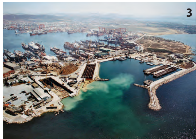
Fertigteilwerft im Hafen von Fenerbahçe, links die Docks, in denen die Bodenplatte und die Außenwände gegossen wurden, rechts wurden auf die schwimmenden Fertigteile die Decken betoniert.
