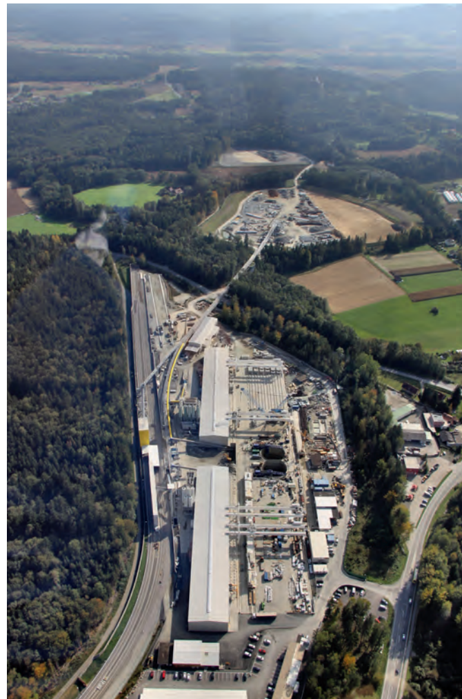
Baustelle eines der längsten Eisenbahntunnel der Welt aus der Luft: Der Koralm-tunnel im Südosten Österreichs soll die Steiermark und Kärnten verbinden.
