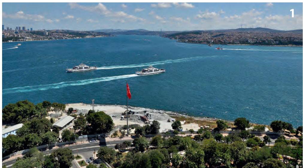
Bosphorusabschnitt des Tunnelprojekts, links die europäische Seite mit dem Istanbul Stadtteil Sirkeci, auf der rechten Seite in Asien Kadiköy
