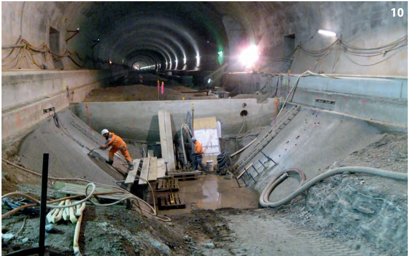
Lage der Manschettenrohre im Tunnelquerschnitt Position of the sleeve pipes in tunnel cross-section
