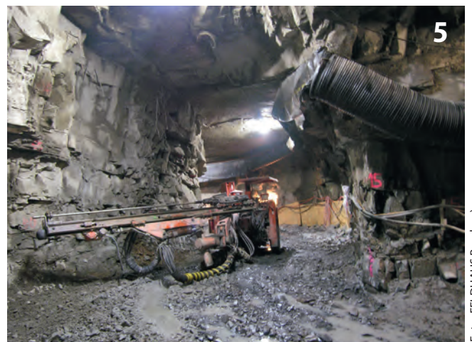
Bohrwagen im Streckenvortrieb Jumbo during tunnelling
