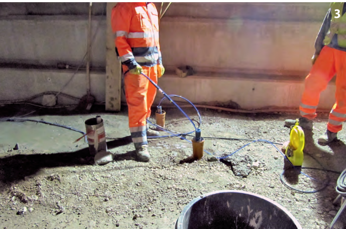
Durchführung einer Probeinjektion Executing a trial injection
