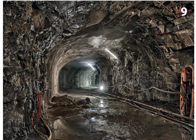
Stollenteil ohne Ausbau Part of tunnel without lining
