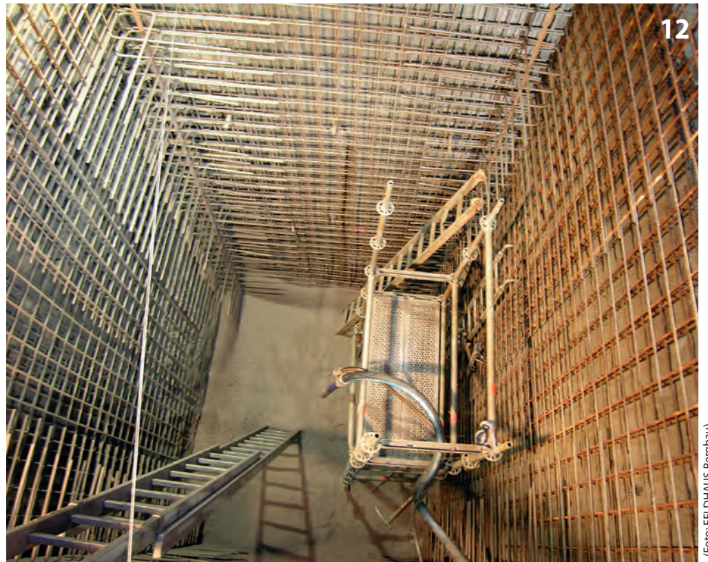
Bewehrungseinbau im Vorschacht Installing reinforcement in the preliminary shaft
