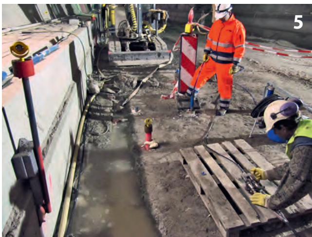
Probeinjektion mit Monitoring Trial injection with monitoring
