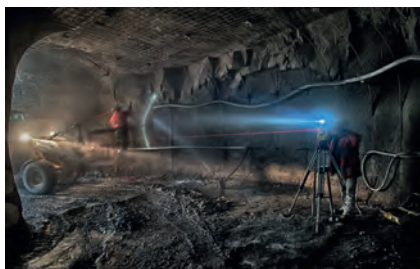
Tunnel-Beamer im Einsatz auf der Baustelle „Erlebnisaufzug Burg Altena“, Seite 24 ff.
