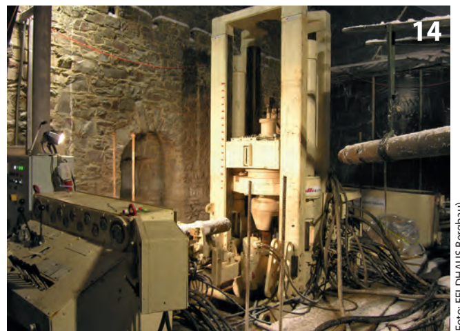
Raisebohrmaschine im Einsatz Raise borer in action
