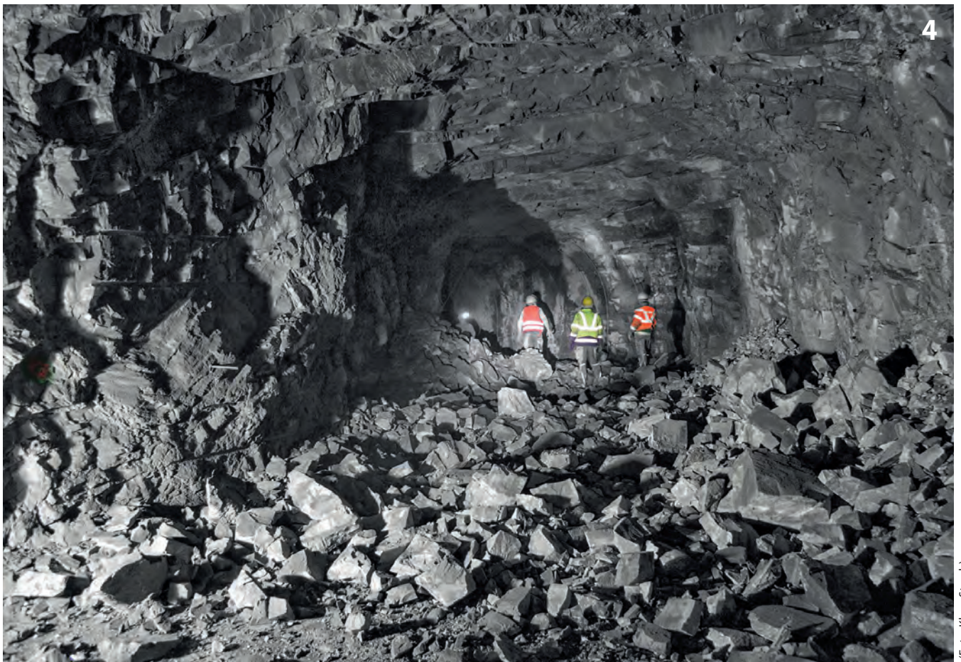
Begutachtung der Ortsbrust nach dem Sprengen Inspecting the face after blasting
