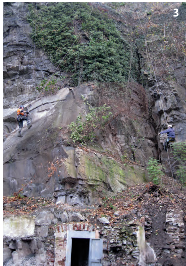
Bergleute beim Beräumen der Steilwand Tunnellers tackling the steep slope
