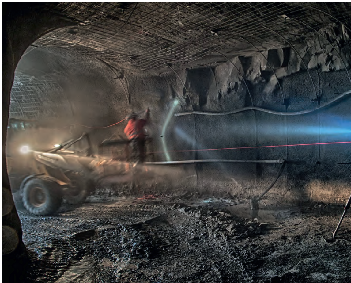
Tunnel-Beamer im Einsatz Tunnel beamer in action
