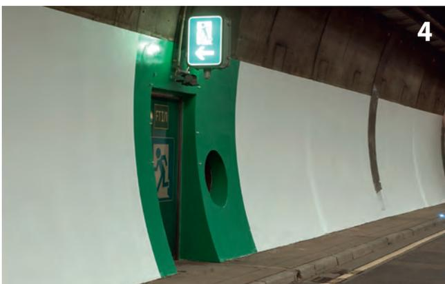
Farbige Gestaltung des Tunnels Heslach mit Sikagard-260 WPU, einer wasser-dampfdiffusionsoffene, karbonisierungs-bremsende und schmutzabweisende Beschichtung.
