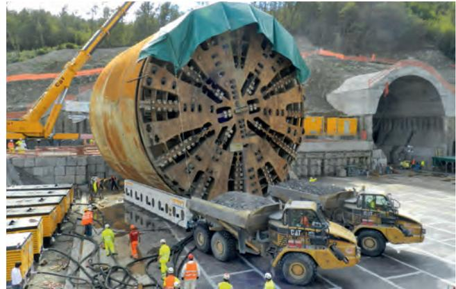
Sparvo Tunnel – Transport des Bohrschildes während der Umsetzung mit Verwendung des US-amerikanischen AeroGo Aero-Caster Luftkissens
