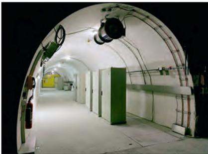
Querschlag im Lötschberg-Basistunnel/CH mit Schaltschränken., S. 10 ff
