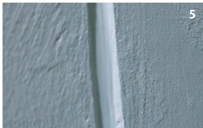
Fugenflanken wurden mit Feinspachtel Icoment-520 Mörtel vorbereitet und mit dem 1-komponentigen elastischen Dichtstoff Sikaflex PRO 1 FC ausgefüllt.
