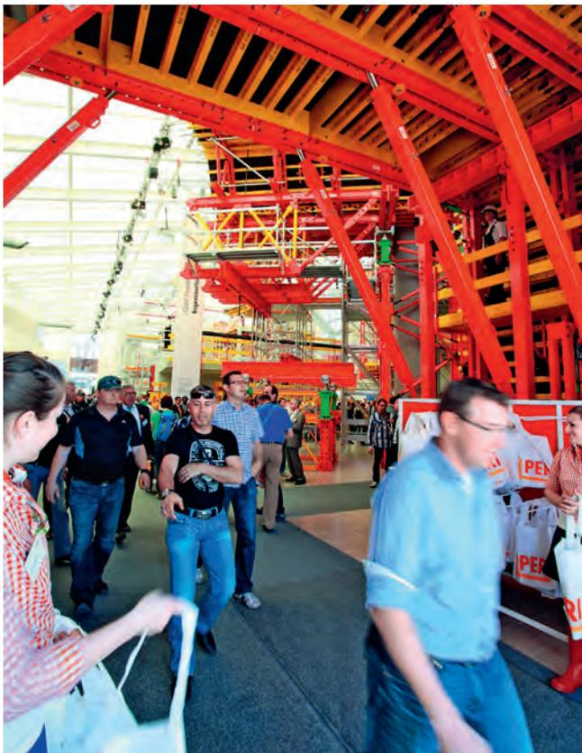
Ein Tunnelschalwagen bildete während der bauma 2013 das Eingangsportal in die eigens zur Messe errichtete Peri Halle. Basis des konstruierten Tunnelschalwagens ist der Ingenieurbaukasten VARIOKIT. Mit neuen Systembauteilen werden die Lösungen noch wirtschaftlicher und einfacher montierbar.
