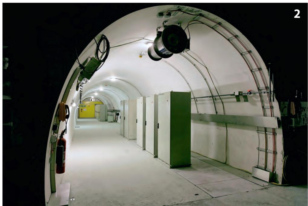
Einer von 104 Querschlügen im Lötschberg-Basistunnel. In jedem befinden sich bis zu 15 Schaltschränke.
