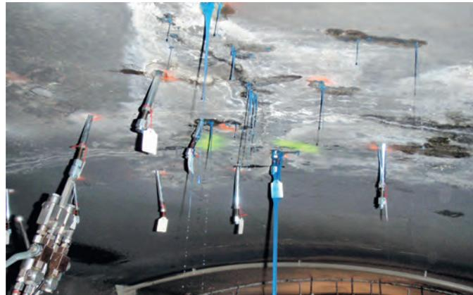
Während des Injektionsprozesses: Anreagiertes Injektionsmaterial und Schilder zur Dokumentation der Injektionsreihenfolge
