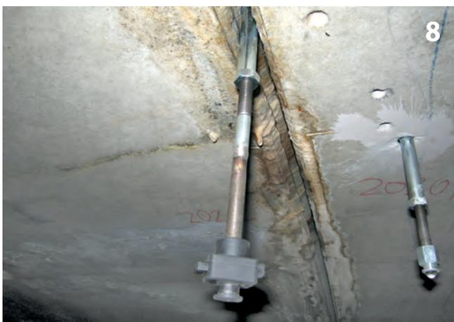
Direkt in der Fuge angeordnete Injektionseinrichtung nach Fehlschlag mit fugenparalleler Bohrung
