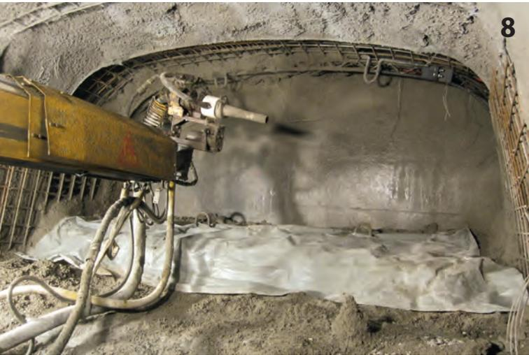
Kalottenquerschnitt mit Stützriegel
