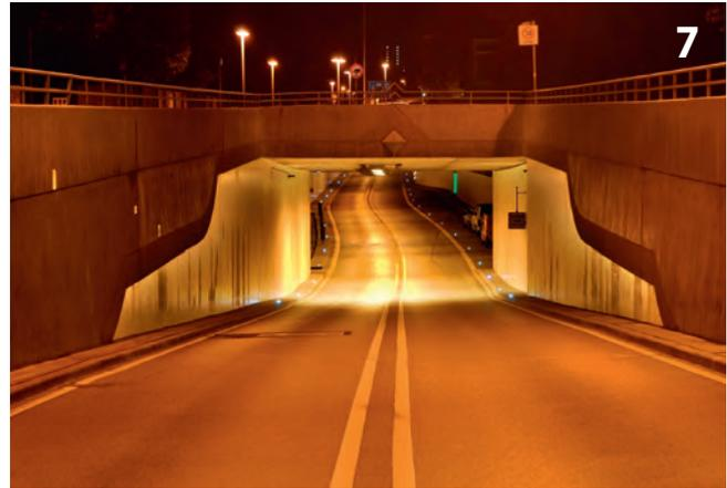
Auch ein zweiter Stuttgarter Tunnel, der B295-Tunnel in Stuttgart-Feuerbach, erhielt zur selben Zeit eine Wandbeschichtung mit Sikagard-260 WPU.
