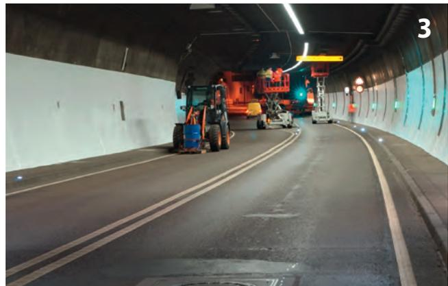
Das im Tunnel Heslach eingesetzte Oberflächenschutzsystem durchlief erfolgreich alle Prüfungen für OS 4 und den vorgeschriebenen Brandschutz.
