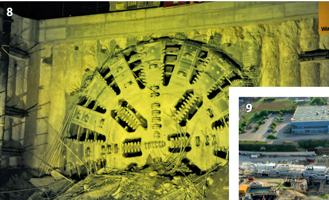
Umfahrung Biel: Geschlossenes Schneidrad der TVM Biel bypass: closed TBM cutting wheel
