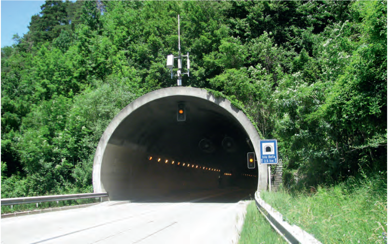
Tunnel Isla Bella in der Schweiz (Portal) Isla Bella Tunnel in Switzerland (Portal)
