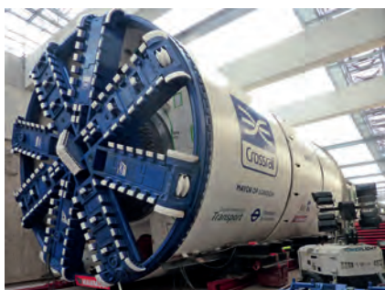
TBM Westbound (S-705) auf dem Weg zur Anfahrwand, Seite 18 ff.
