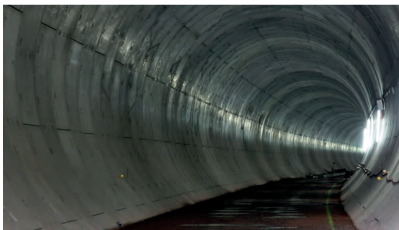
Fertiger Tunnelrohbau NKWT mit Ausgleichsschicht vor Beginn der Arbeiten am Oberbau Completed tunnel roughwork with compensation layer prior to starting on the superstructure
