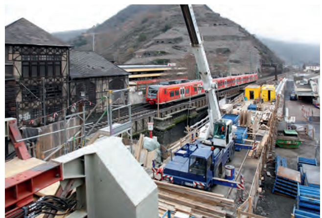
Endphase Bau der Eisenbahnüberführung Brückenstraße Cochem
