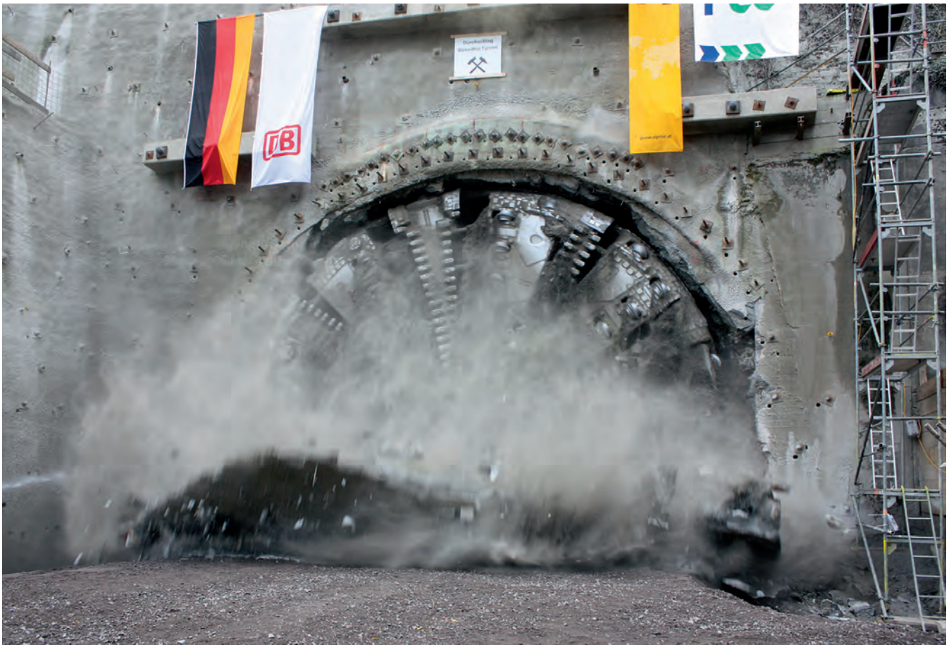
Tunneldurchschlag am 7. November 2011
