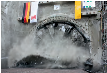
Kaiser-Wilhelm-Tunnel beim Durchschlag am 7. November 2011, Seite 24 ff
