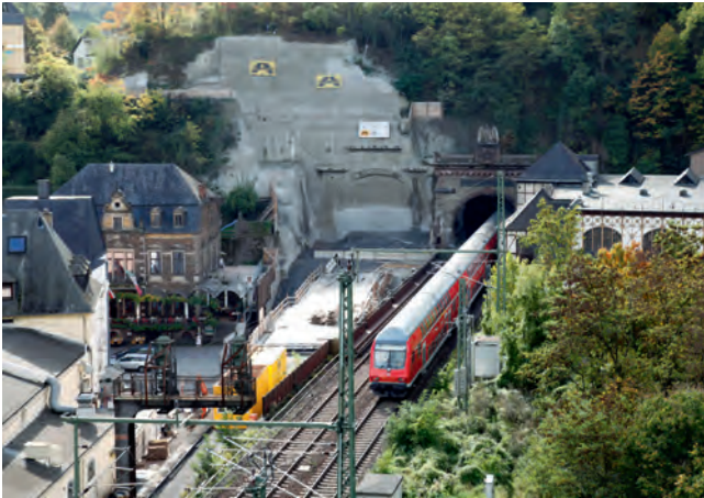
Voreinschnitt Cochem von oben: Tunnelanschlagwand Ausfahrt TVM in unmittelbarer Nähe der Wohnbebauung
