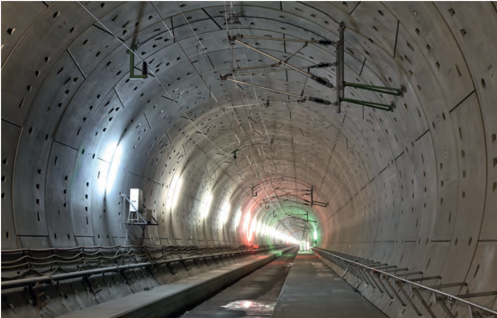
Erstmals wurden in Deutschland die Hochgeschwindigkeits-Oberleitungen Re 330 mit Dübeln in Tübingen verankert The high-speed overhead line Re 330 was anchored to the segments with bolts for the first time in Germany
