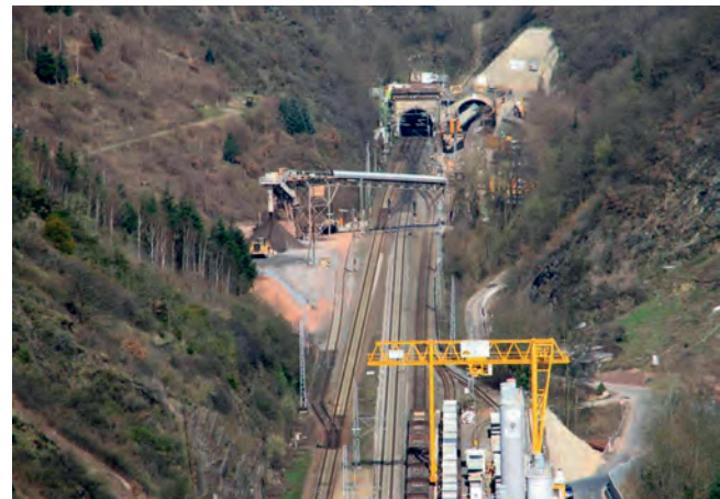
Voreinschnitt Ediger-Eller von oben mit Baustelleneinrichtung für den Tunnelvortrieb NKWT
