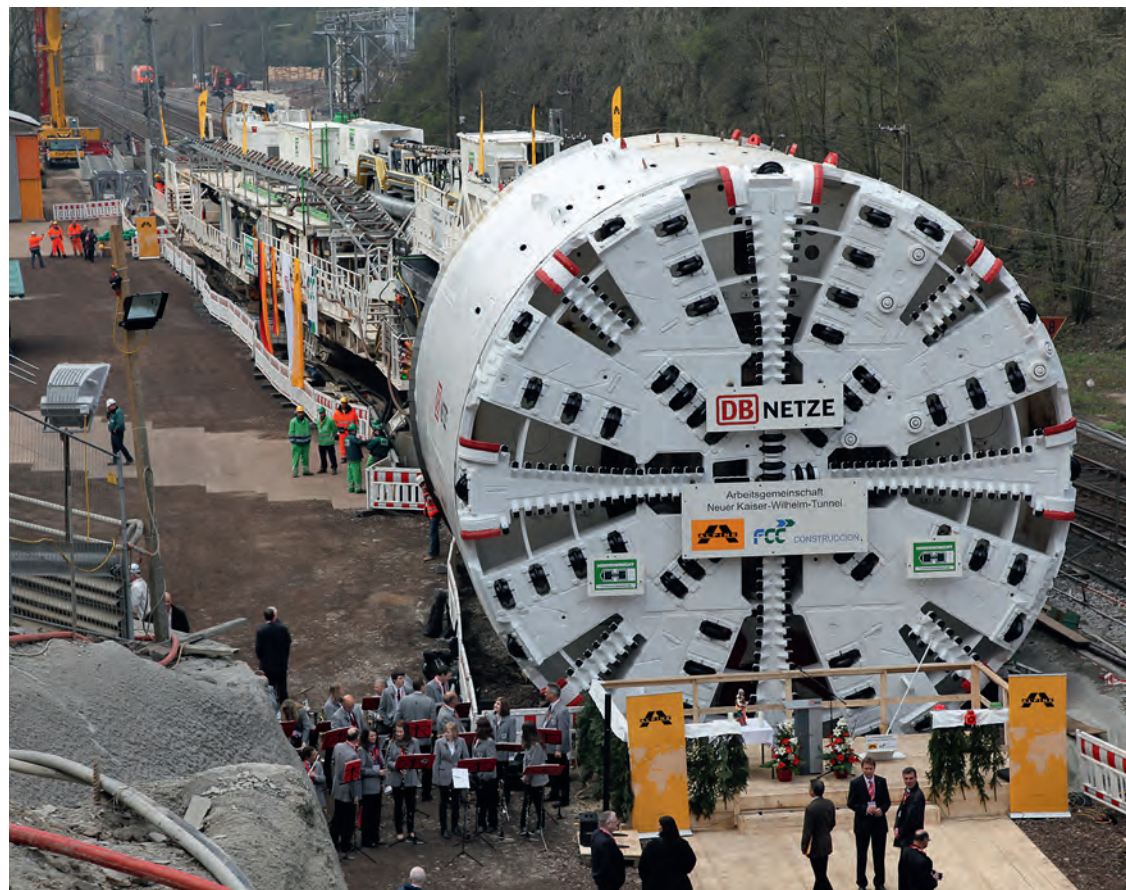
Tunnelvortriebsmaschine bei der Andrehfeier am 10. April 2010
