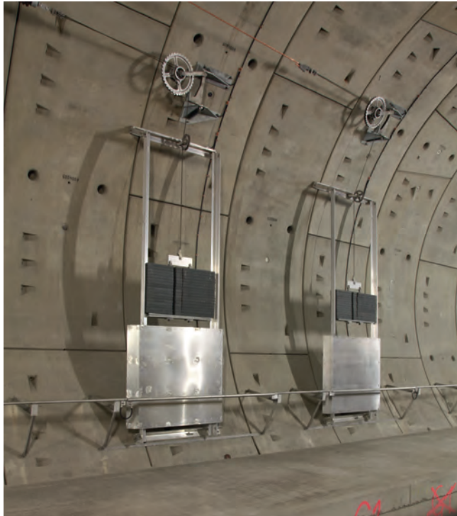
Detail der zur Verankerung der Radspanner eingebauten Highbond-Anker FHB II M 20 A4
