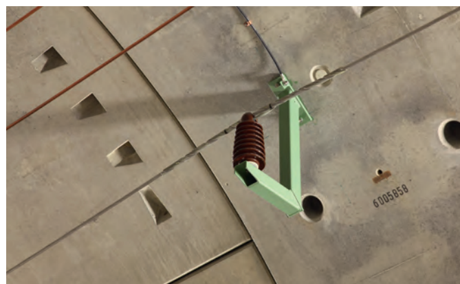
Die Verstärkungsleiter wurden mit Ankerbolzen FAZ II M 16/50 A4 befestigt
