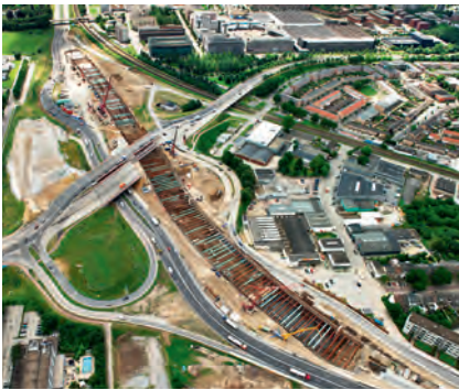
Grundwassermanagement bei offener Bauweise für Tunnel A2 Maastricht/NL, Seite 36 ff
