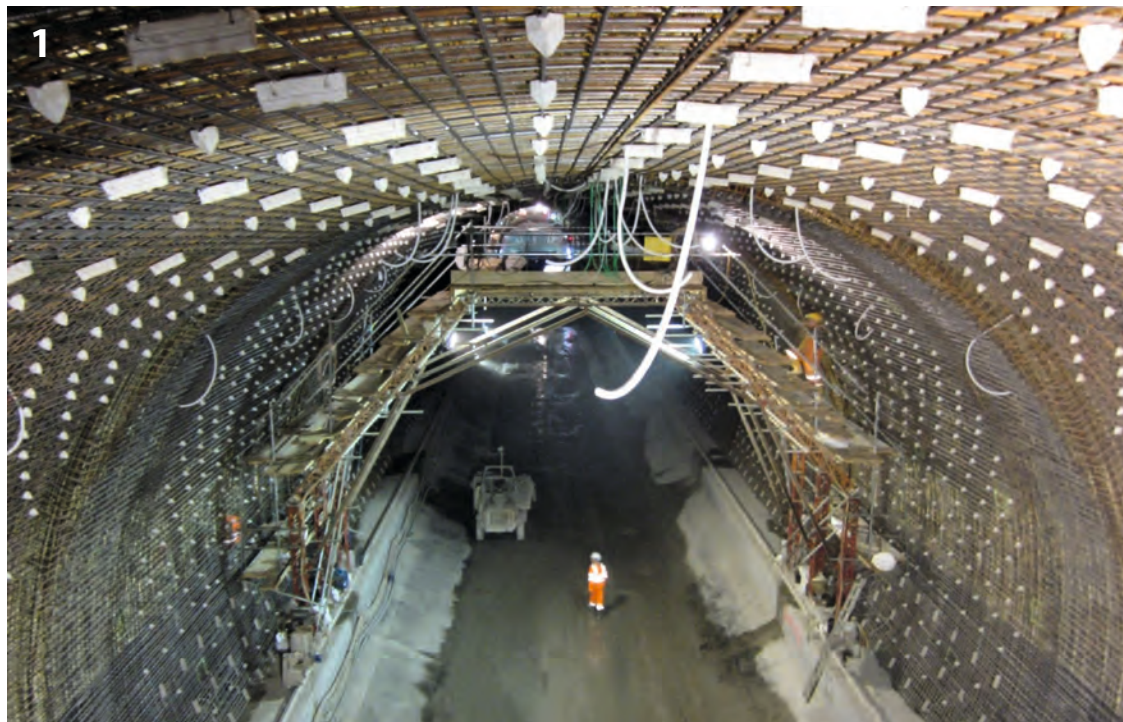
1 Injektionsschläuche für das Blockhinterlegungssystem und in der Firste zum Verfüllen des Firstspaltes mit Zementsuspension
