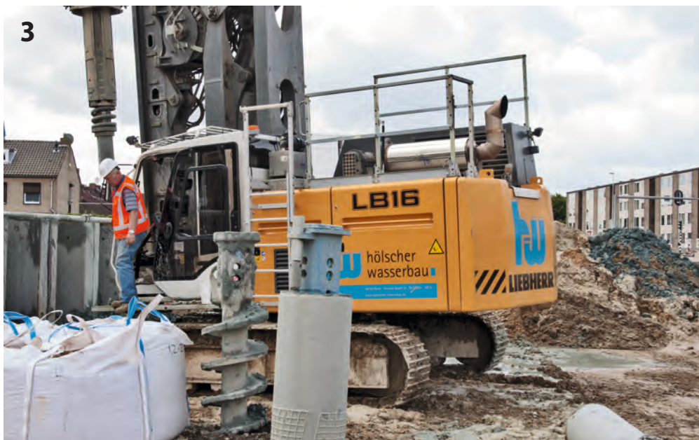
Der Liebherr LB 16 von Hölscher Wasserbau bei der Herstellung der Brunnenbohrung
