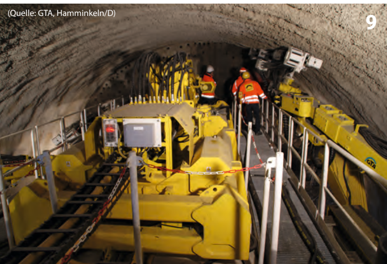
Tunnelerweiterungsportal TEP 8400B für die Tunnel Langenau und Hollerich Tunnel enlargement portal TEP 8400B for the Langenau and Hollerich tunnels
