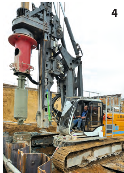
Herstellung der Brunnenbohrung Drilling of wells
