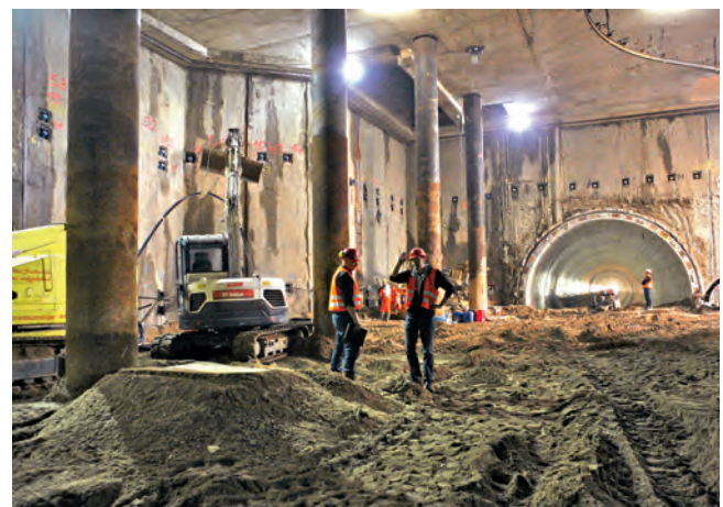
Blick in den Rohbau eines unterirdischen Bahnhofs nach dem Rückbau der temporären Stahlfaserbeton-Tübbinge
