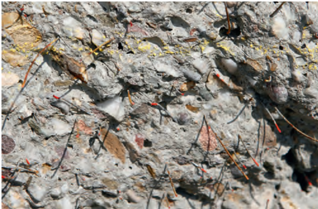
Gleichmäßig verteilte Stahlfasern für die temporären Tübbinge in den Bahnhofsbereichen
