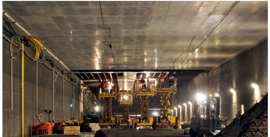
Generalsanierung des Söderledstunnels in Stockholm, Schweden, Seite 22ff. General Refurbishment of the Söderleds Tunnel in Stockholm, Sweden, see pp 22.
