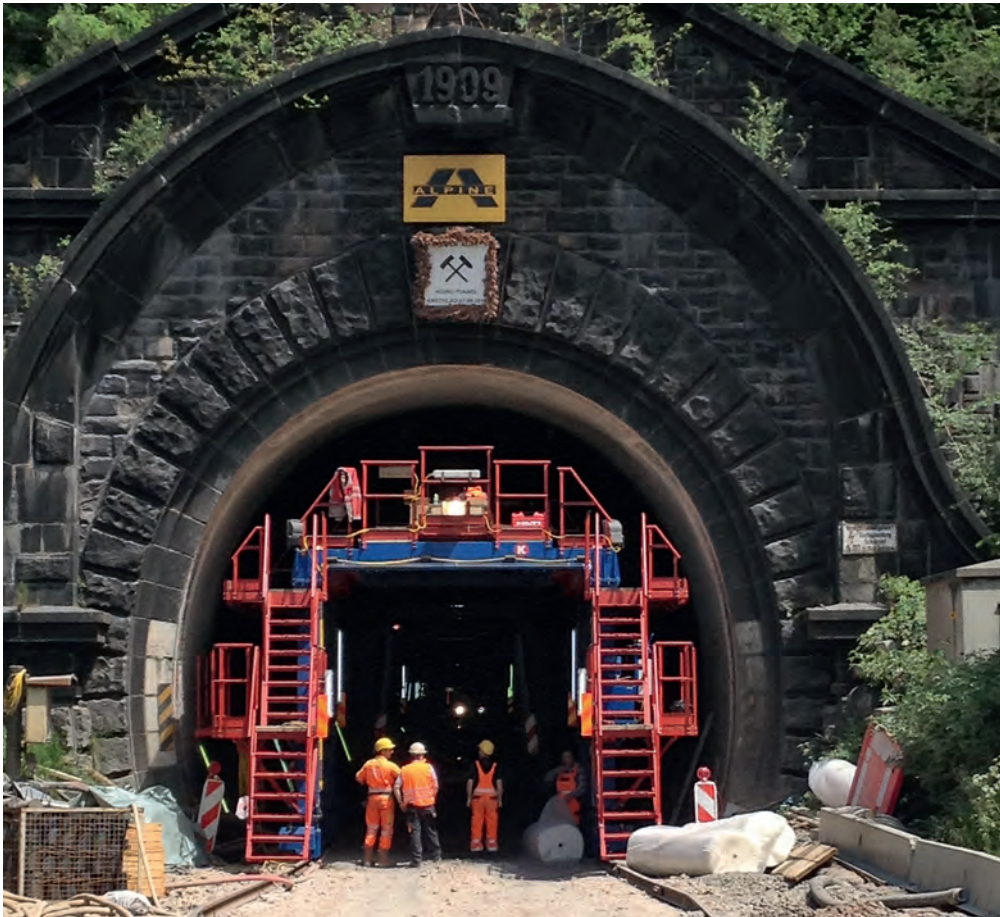
Alter Schlüchterner Tunnel (AST) mit neuer Ortbetoninnenschale und PP-Fasern Old Schlüchterner Tunnel (AST) with new in situ concrete shell and PP fibres
