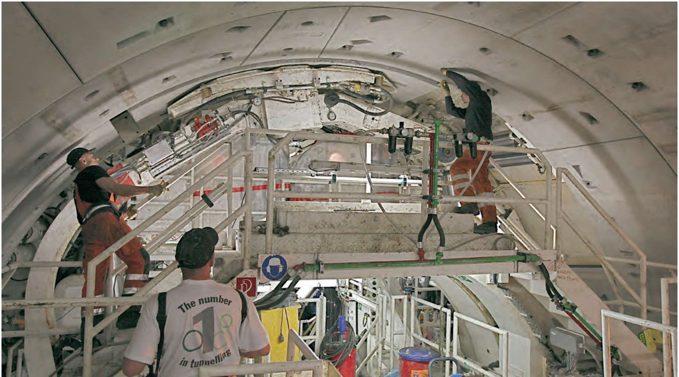
Tübbing-Montage im Tunnelfirst: Die 7+1 Elemente ergaben einen 46,2 t schweren Ring Segment assembly in the tunnel roof: the 7+1 elements provide a 46.2 t heavy ring
