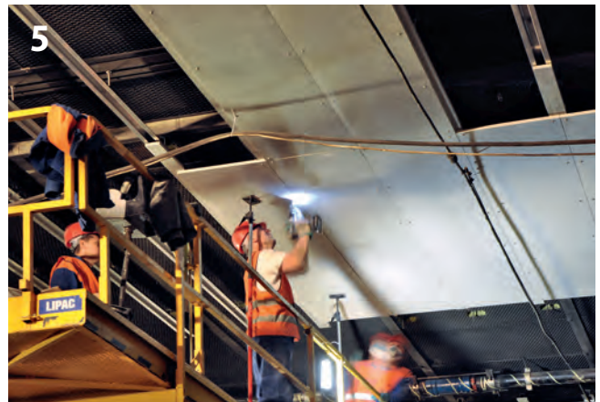
Montage der Brandschutzplatten auf den Profilen Mounting the fire protection boards on subframe
