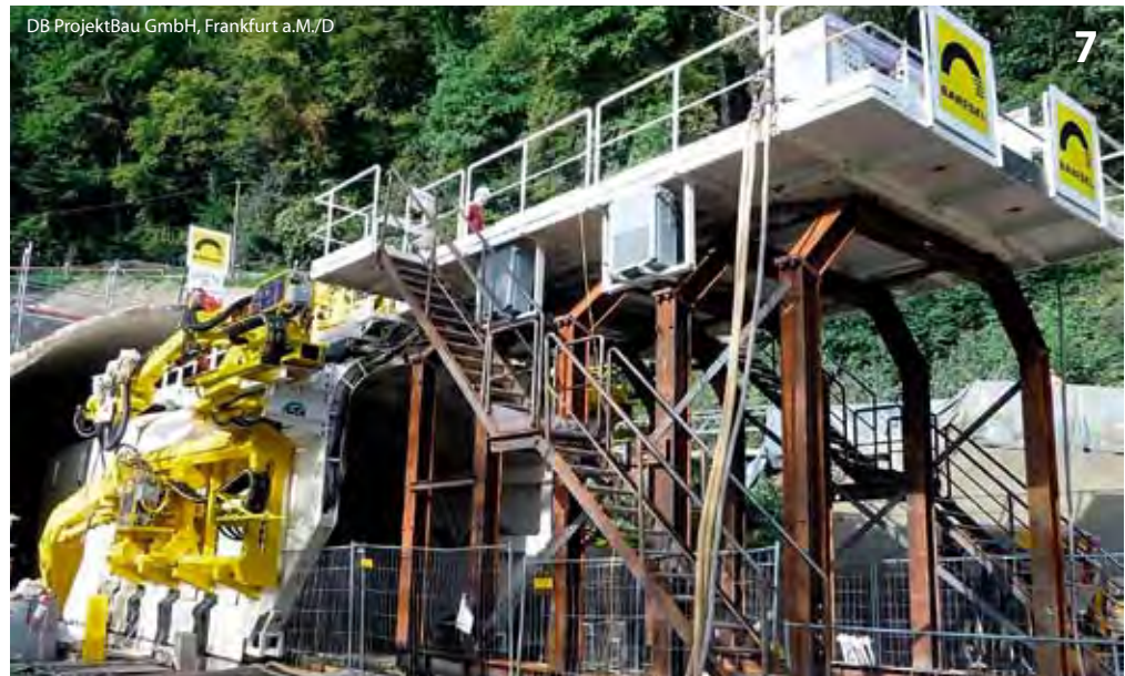
Tunnelvortriebsportal für die Aufweitung des Langenauer und Hollricher Tunnels Tunnel driving portal for enlarging the Langenau and Hollrich Tunnels
