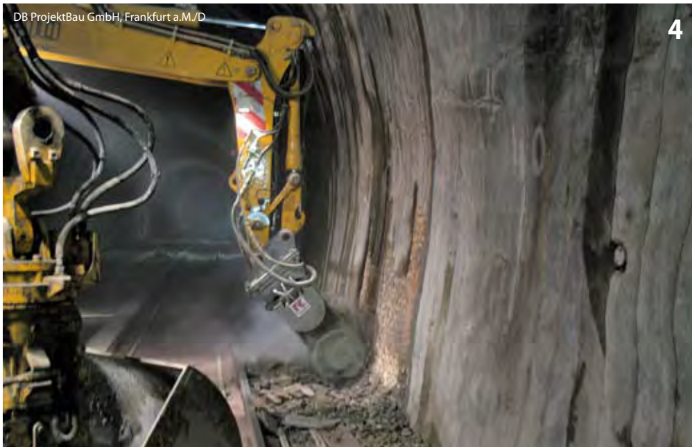
Abschrämen des alten Mauerwerks mit einer Fräse Removing the old masonry with a cutter
