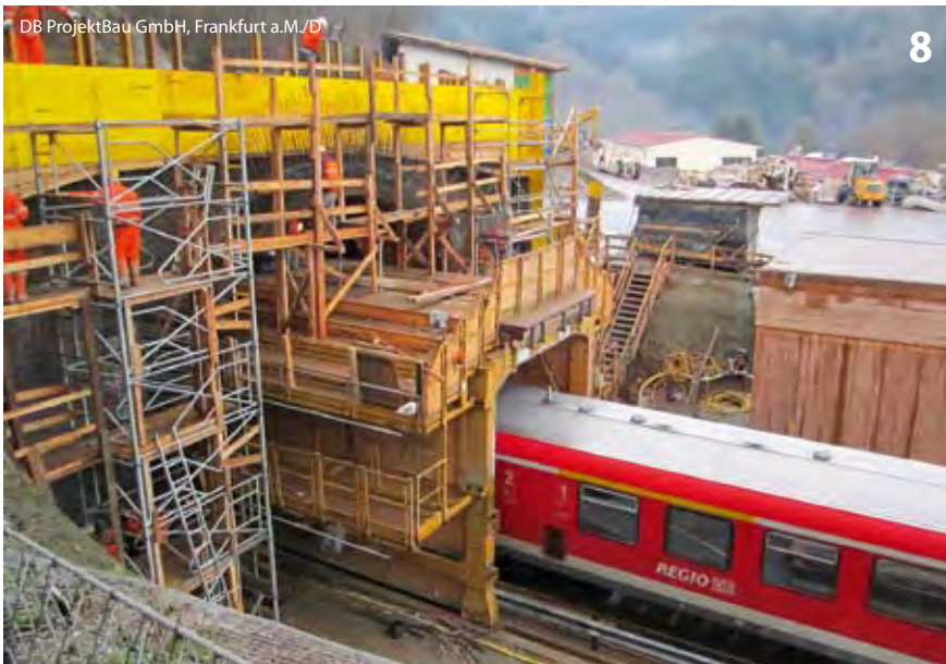
Schalwagen bei der Betonage des Portalblocks und der Portalscheibe am Frauenberger Tunnel Formwork car for concreting the portal block and the portal section at the Frauenberg Tunnel
