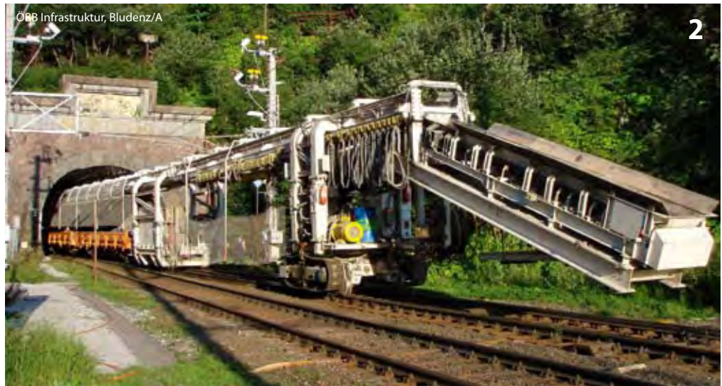
Gleiskörperabtragseinrichtung zur Erneuerung des Arlbergtunnels
