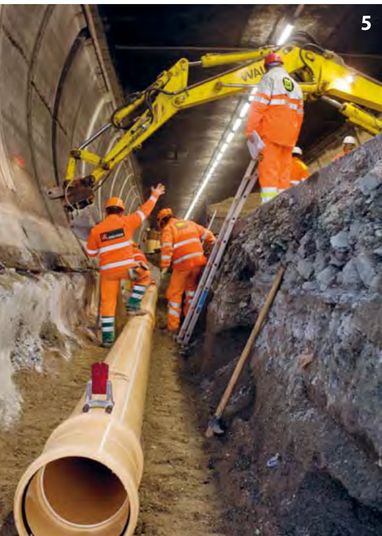
Entwässerungsleitungen Drainage lines
