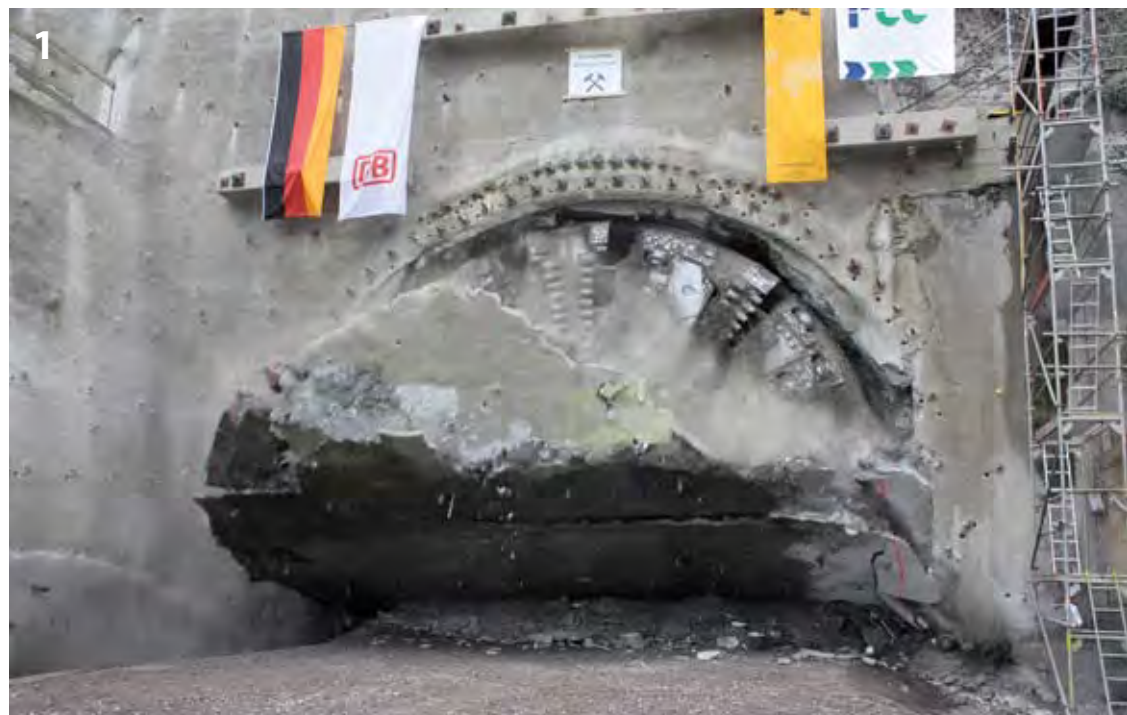
Durchschlag TVM Portal Cochem
