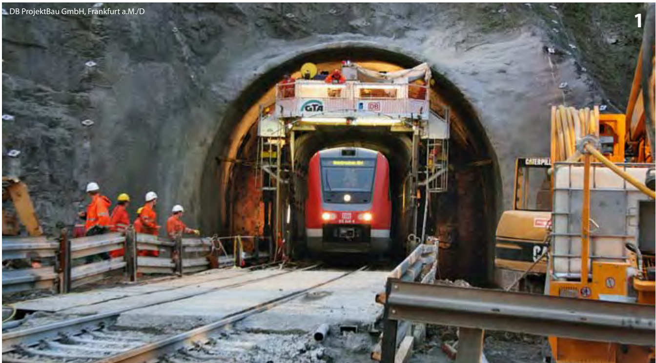
Jährder Tunnel während der Aufweitung mit der Tunnel-im-Tunnel Methode Jährod Tunnel being enlarged by the Tunnel-in-Tunnel method
