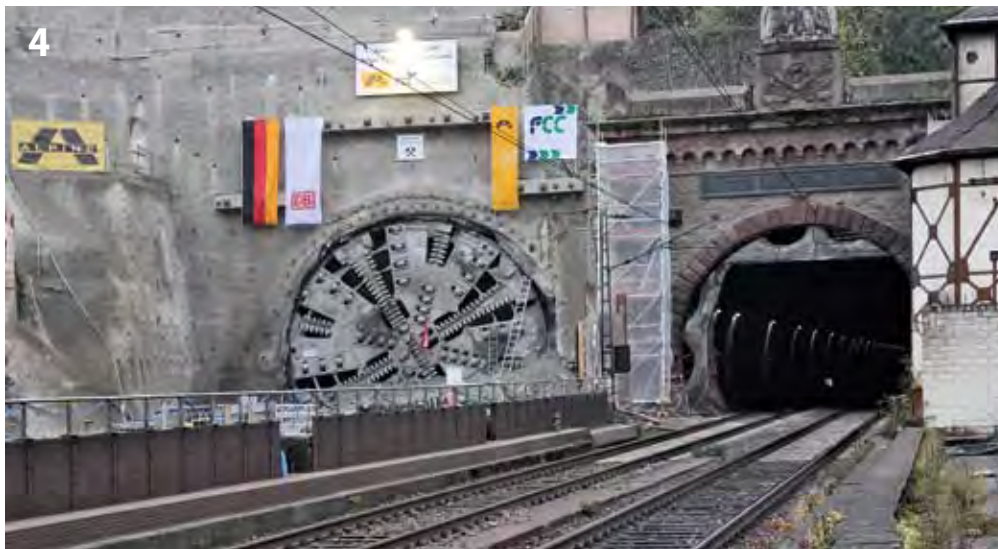
Portal Cochem: Neuer (links) und Alter Kaiser-Wilhelm-Tunnel
