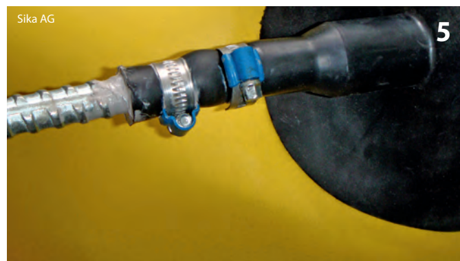
Wasserdichter Abschluss der Durchdringung mittels Flansch (Sikaplan Trumpet)
