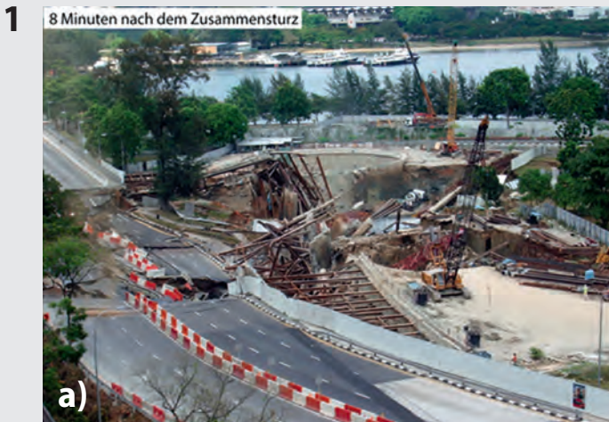
Nicoll Highway Collapse (Circle Line/Singapur, 20. April 2004; COI, 2005): a) Baufeld ca. 8 Minuten nach der Havarie und b) aufgenommene Steifenkräfte in der Baugrube. Zu erkennen ist eine signifikante Entwicklung der Steifenkräfte bereits 4 h vor Eintritt der Havarie
