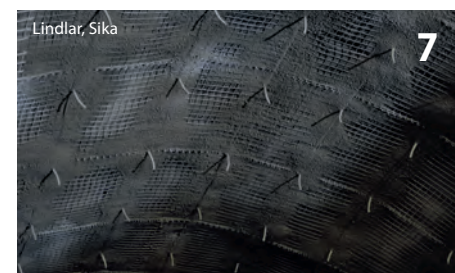
Rasterweises Einspritzen der Rückprallreduktionsmaßnahme
