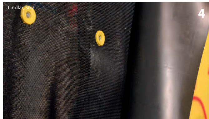
Die Drainagematte ist an den Abdichtungsträger mit Rondellen (PVC) befestigt (links). Die Abdichtungsbahn (bergseitig schwarz, luftseitig signalgelb) wird danach an den Rondellen angeschweißt
