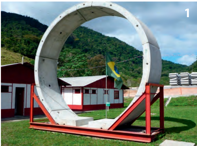
Tübbingring bei einem Projekt in Brasilien Segment ring at a project in Brazil
