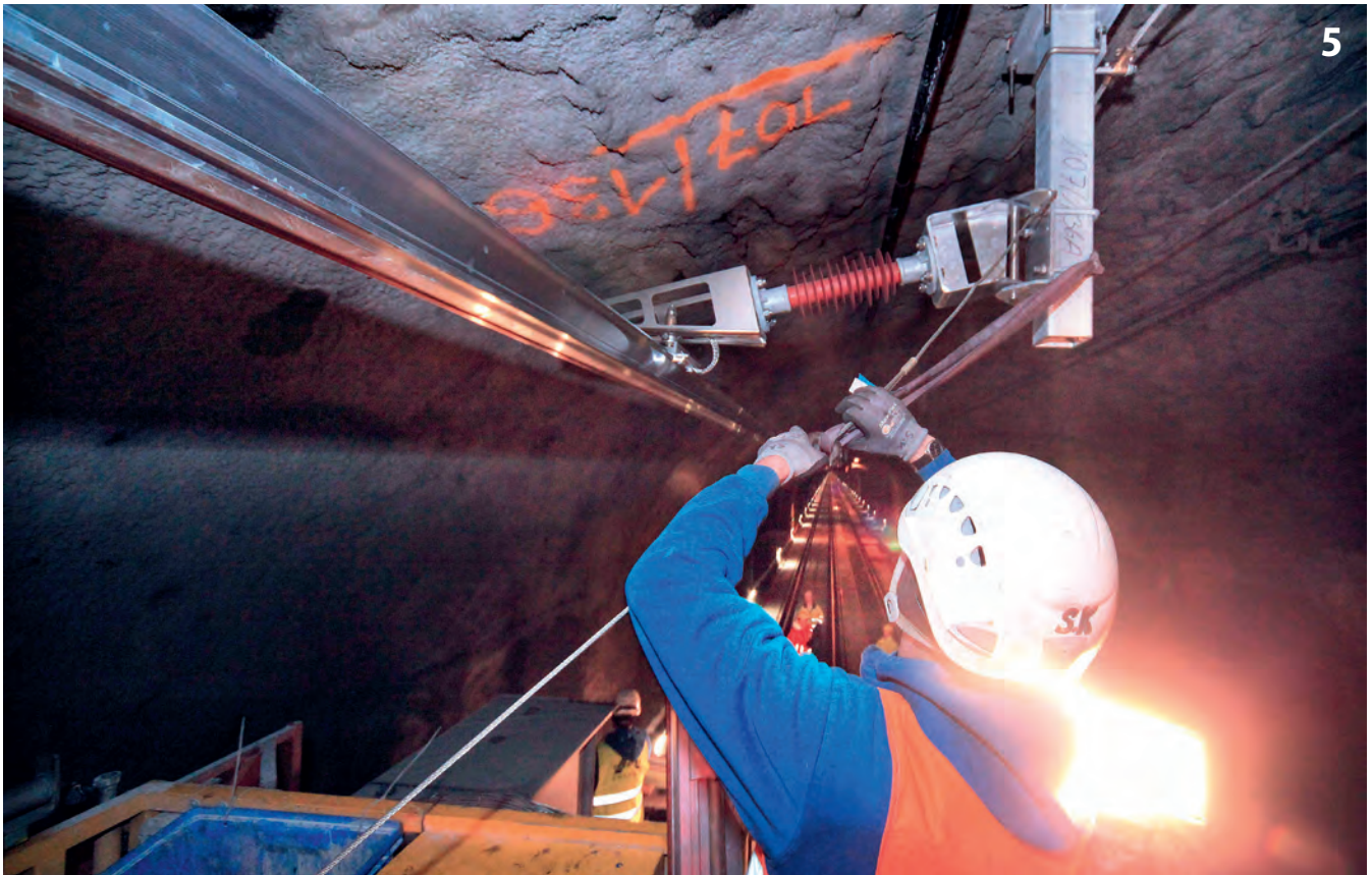
Stromschiene mit Aufhängung
