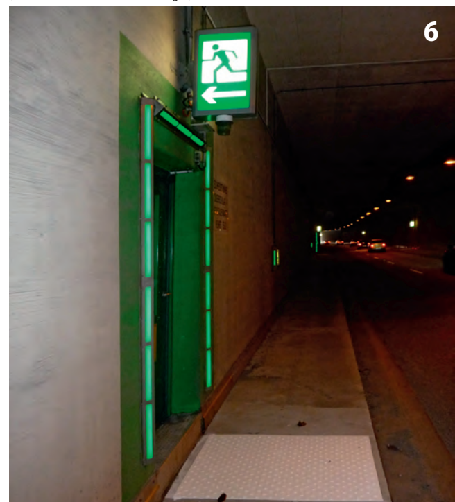
Nachrüstung der Fluchttüren mit aktiver Beleuchtung und Aufmerksamkeitsfeldern
