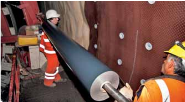
Die Abdichtungsbahn wird verlegt...
