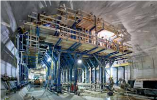
Sehr kurze Taktzeiten durch einfache und schnelle Anpassung des Schalwagens an die extreme Querschnittsverjüngung
