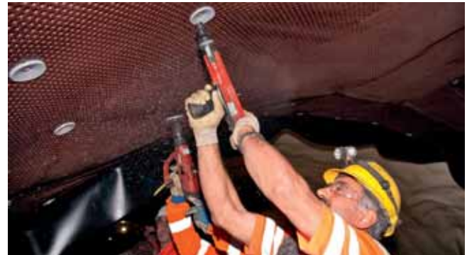
Endgültig befestigt werden sie durch Rondelle, an die später die Abdichtungsschicht geschweißt wird
