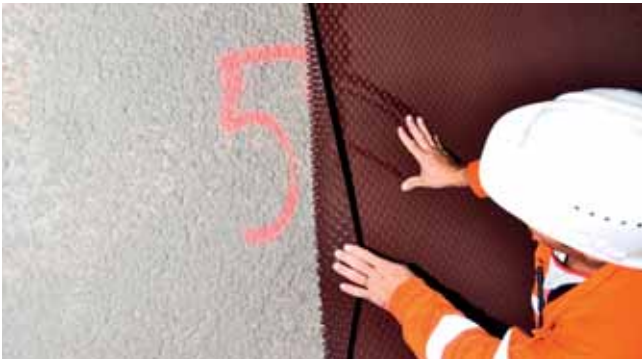
Die Drainagebahn wird direkt gegen die stabilisierende und filternde Spritzbetonschicht montiert
